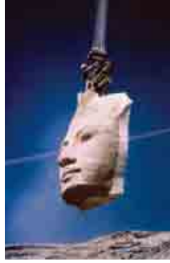
Abu Simbel, Egipto: Desmantelamiento del Templo de Ramsés II con una grúa. © UNESCO/Nenadovic
