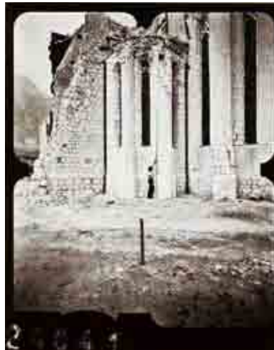
Friuli, 1976. Izq.: Ábside de la iglesia de Venzone después del primer sismo. Dcha.: El mismo ábside después del segundo sismo. El ICCROM participó en el análisis fotogramétrico realizado después del primer sismo. La reconstrucción de la iglesia se basó en los dibujos obtenidos.
