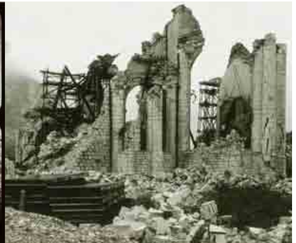
Friuli, 1976. Izq.: Ábside de la iglesia de Venzone después del primer sismo. Dcha.: El mismo ábside después del segundo sismo. El ICCROM participó en el análisis fotogramétrico realizado después del primer sismo. La reconstrucción de la iglesia se basó en los dibujos obtenidos.
