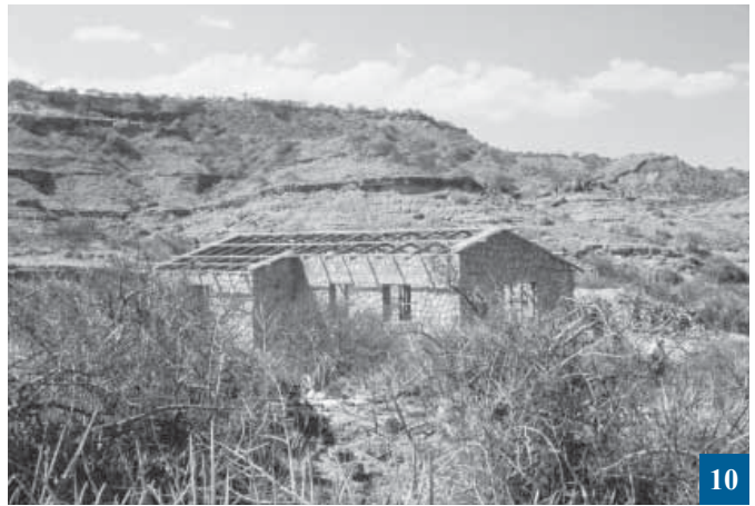
بناء سقيفة حماية لموقع (دو غلاس كرونجو) لبقايا الأسلاف البشرية في (أولدواي غورغ) بتنزانيا. تصوير: ن. أغنيو. الحقوق محفوظة لمؤسسة بول غيتي ©
