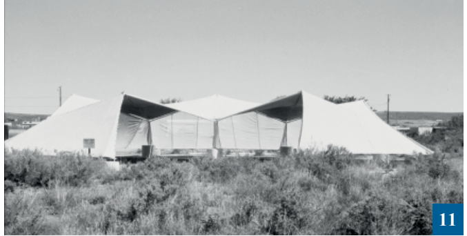
سقيفة الحماية سداسية الشكل بموقع (فورت سيلدن) في ولاية نيومكسيكو. السقف غشاء مُحكم والجوانب مصنوعة من نسيج صناعي مفتوح الجدل. تصوير: ن. أغنيو. الحقوق محفوظة لمؤسسة بول غيتي ©
