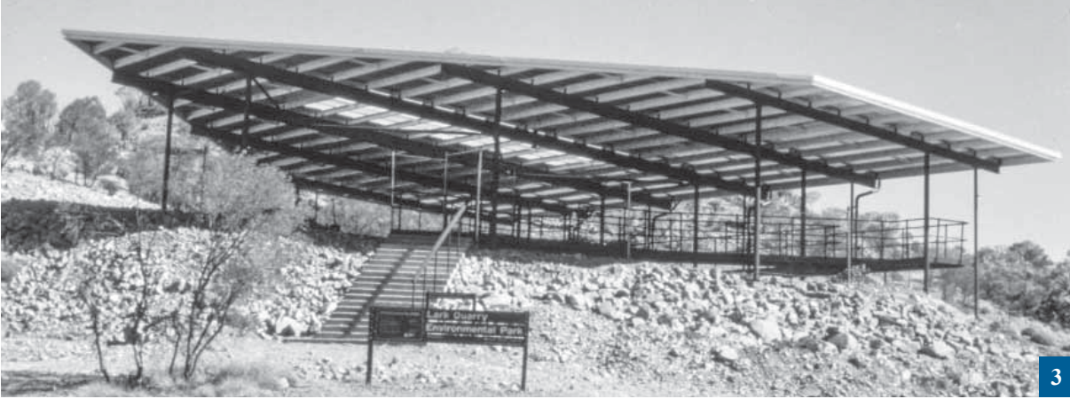
سقف في منطقة (لارك كويري) Lark Quarry عام 1981، قبل تشييد سياج محيط للحيلولة دون أن تحتمي حيوانات الكنغر بالسقف. وتتوفر الإضاءة الطبيعية من خلال لوحات شفافة، ويشاهد الزوار الآثار من ممشى مرتفع. تصوير: ن. أغنيو
