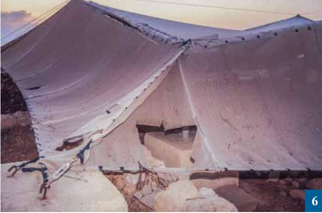
تدهور مواد التغطية المستخدمة في السقيفة السداسية تدهوراً شديداً في عام 2004، بعد خمسة عشر عاماً من إنشاء السقيفة. التقطت الصورة (مارثا ديماس) عام 2004. الحقوق محفوظة لمؤسسة بول غيتي ©
