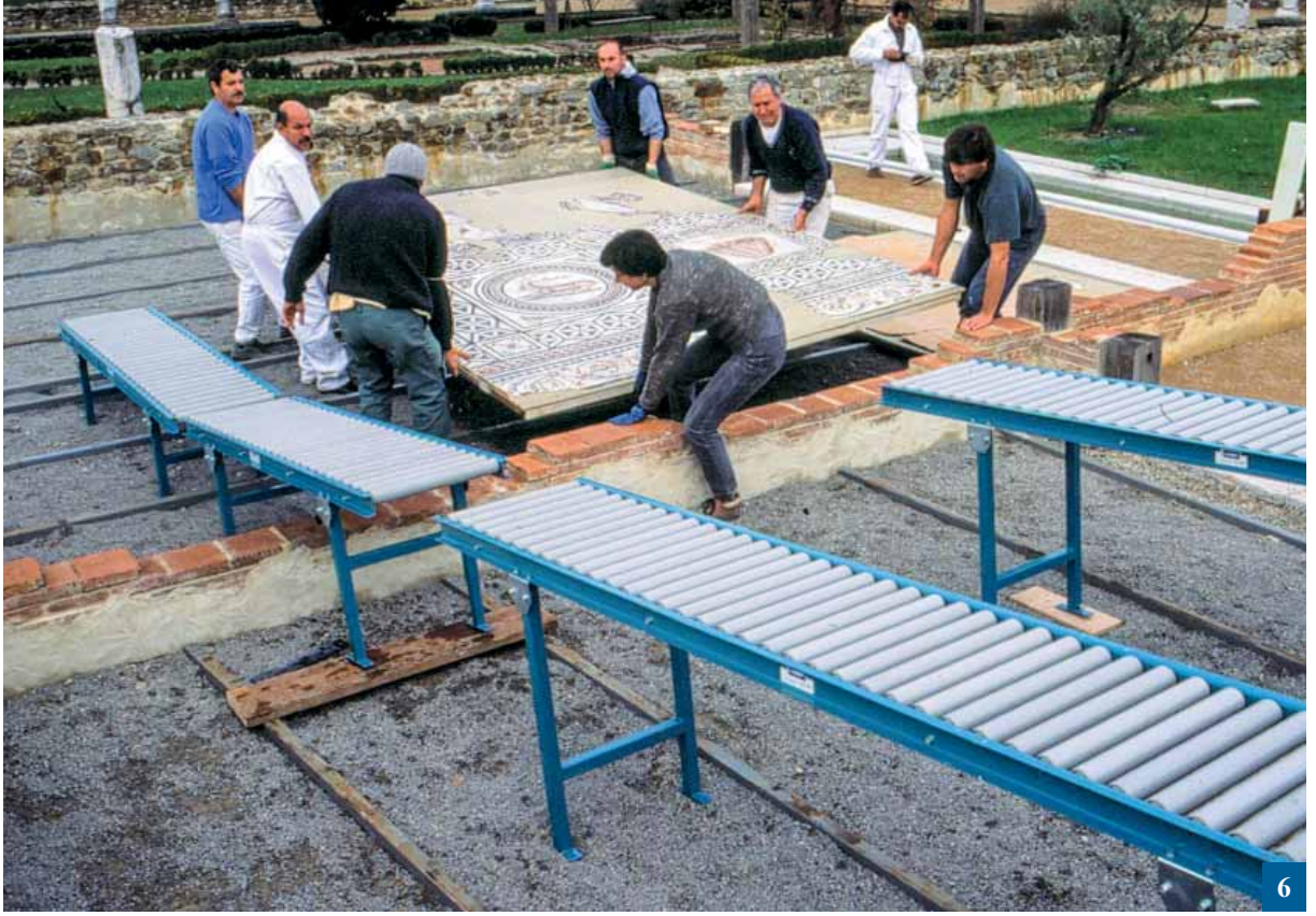
التعامل مع لوحات الفسيفساء بالاستعانة بسلاالم متحركة قابلة للتعديل
