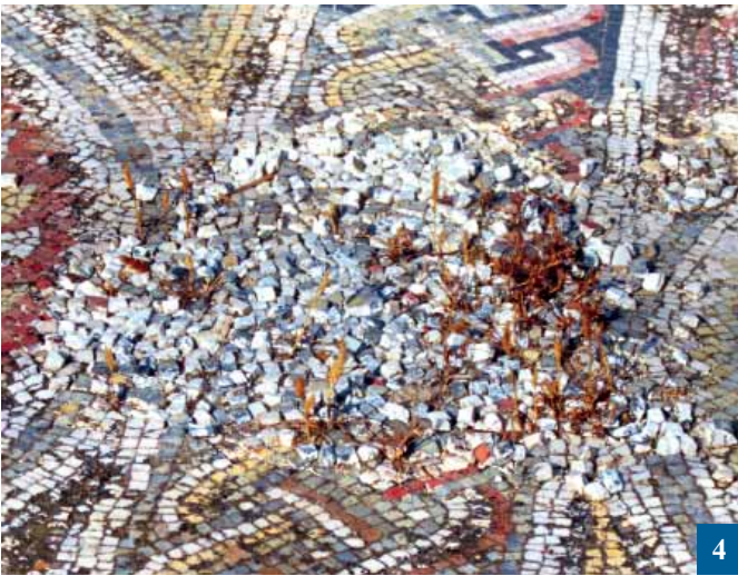
سرعان ما يؤدي انفصال أحد مكعبات الفسيفساء إلى انفصال مكعبات الفسيفساء المحيطة به، وهذه هي الخطوة الأولى في تكوين الفجوات
