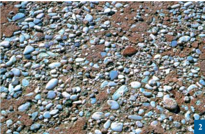
2 أرضية قديمة للاستخدام العام (وليس لقيمة جمالية) تتألف من ملاط وحجر توضح تدهور حالة الملاط وتفتت البنية. فيلا ثيسوس، بافوس، قبرص. تصوير: ج. ستورات
