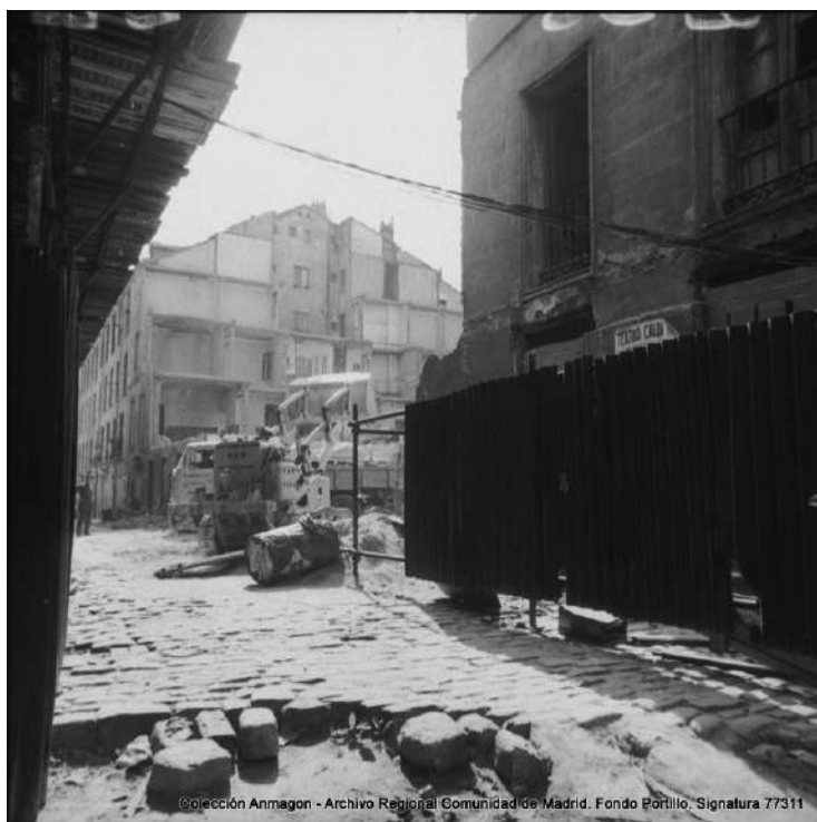
FIGURA 3B. VISTA DE LA CALLE DE HERMOSA, EN EL BARRIO DE LAS POZAS, MADRID, DURANTE EL PROCESO DE DERRIBO DE LAS VIVIENDAS, OCTUBRE 1969. Imagen: Colección Anmagón, Archivo Regional de la Comunidad de Madrid, Fondo Portillo, signatura 77311-023.
