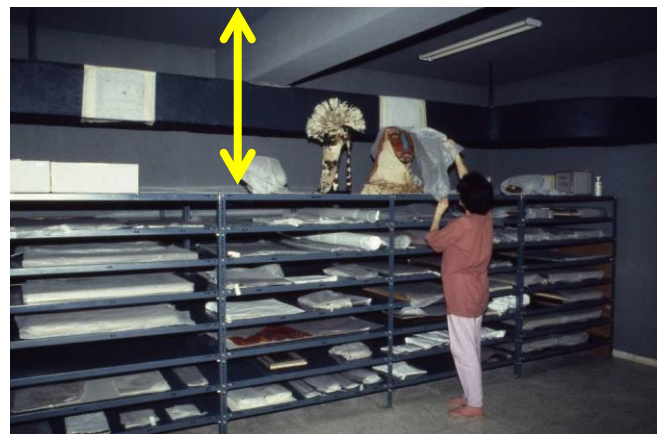
La hauteur dégagée, ou l'espace vertical utilisable, n'est pas toujours égale à la hauteur de la pièce en raison de divers obstacles (dans ce cas, des conduits d'aération) © ICCROM
