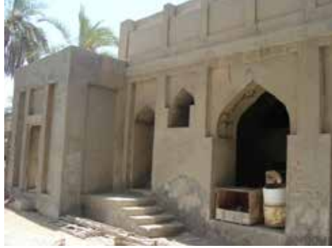
صورة رقم (176) تُظهر أحد الواجهات الداخلية للبيت وهي مغطاة بطبقة الإسمنت الحديث
