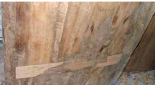
صورة رقم (276) توضح عملية الاستكمال والتقوية لاحد الأبواب الخشبية من الخلف
