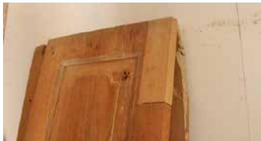
صورة رقم (275) توضح عملية استكمال أحد الأجزاء التالفة لاحد الأبواب الخشبية في دكاكين سيادي
