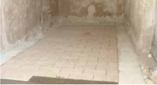
صورة رقم (274) توضح شكل أرضية الدكاكين بعد تغطية الخدق ورصف أرضية الدكان
