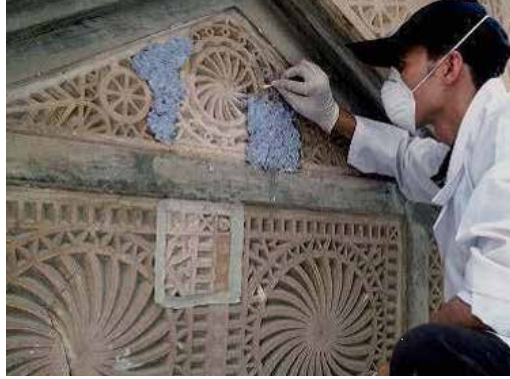
صورة رقم (221) توضح عملية التنظيف بالكمادات والقطن
