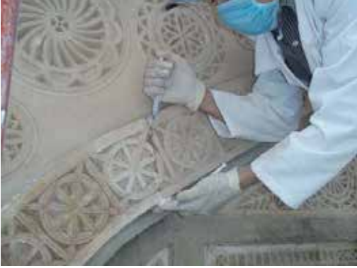
صورة رقم (222) توضح عملية حقن المادة المقوية في الشروخ
