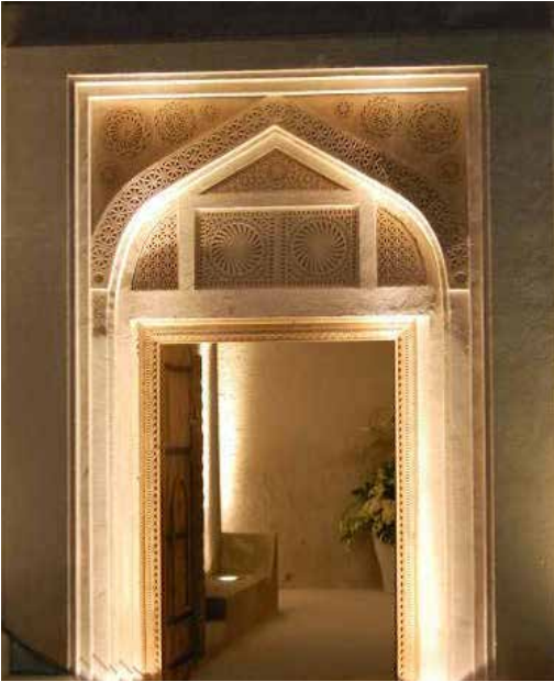
صورة رقم (224) توضح مظهر الزخارف أعلى الباب الرئيسي لبيت الشيخ سلمان أثناء الليل بعد الترميم
