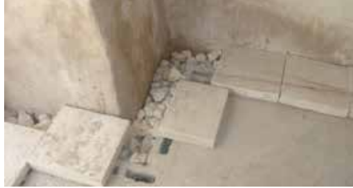
صورة رقم (273) توضح الخدق أو الممر عند أسفل الجدران بداخل الدكاكين بعد ملئه بالحصى
