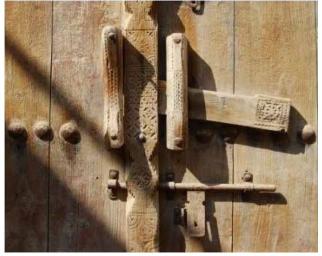
صورة رقم (4) أدوات قفل الباب من الخارج "المزلاج"
