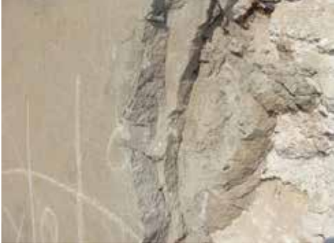
صورة رقم (177) تُظهر سمك الطبقات الإسمنتية الحديثة
