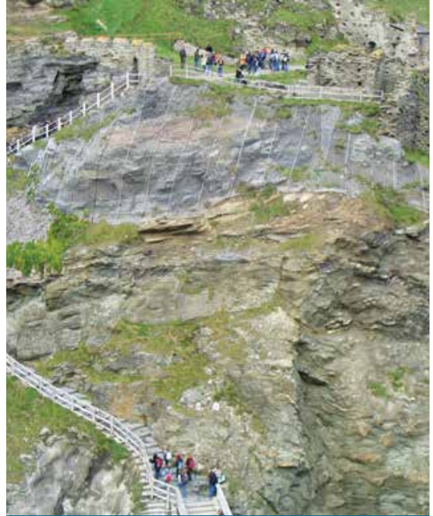
شكل 5: شبكات الاحتواء المعدنية هي إحدى الوسائل لمنع انهيار المنحدرات الصخرية، كما هو الحال في هذا الموقع العائد إلى القرون الوسطى في تينتاغل (Tintagel) بإكلترا. حقّ الملكية: Equip etueraessim. (© Arthur McCallum-English Heritage).
