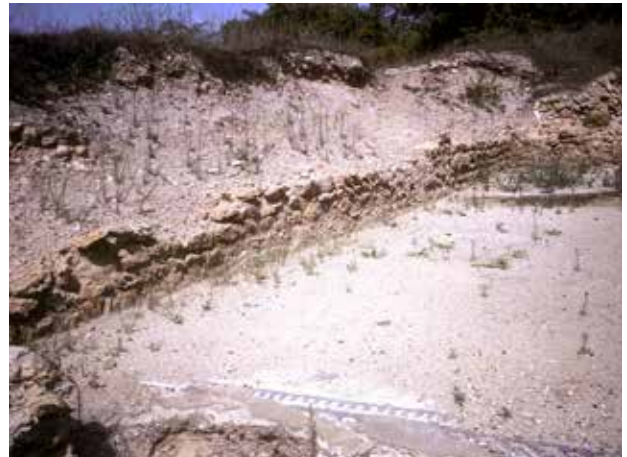
شكل 8: انجراف منحدر على فسيفساء، وهو ما يمكن منعه بسهولة عن طريق زرع النباتات أو تعزيز التربة
