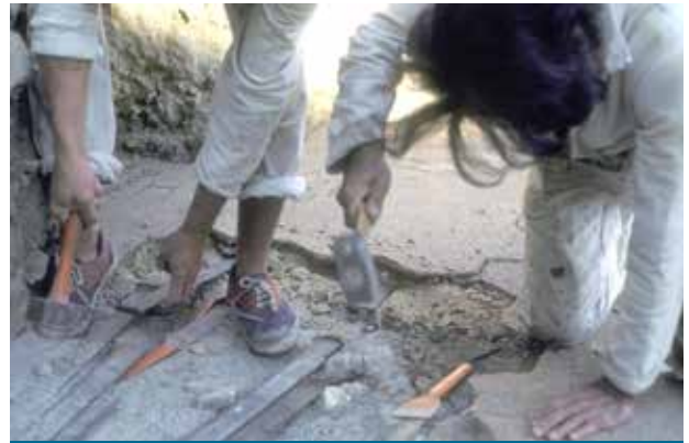
شكل 11: القصّ حتى الجزء الأسفل من رصيف فسيفسائي معزز بقضبان الحديد يتطلب مهارة فائقة لتجنب وقوع الضرر
