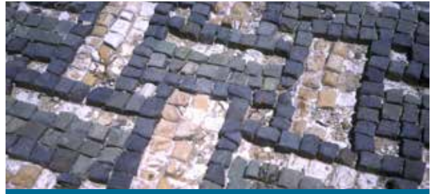
شكل 4: تآكل مميّز لمكعبات من الحجر الكلسي الأبيض بسبب الأملاح القابلة للذوبان الموجودة في الأرض
