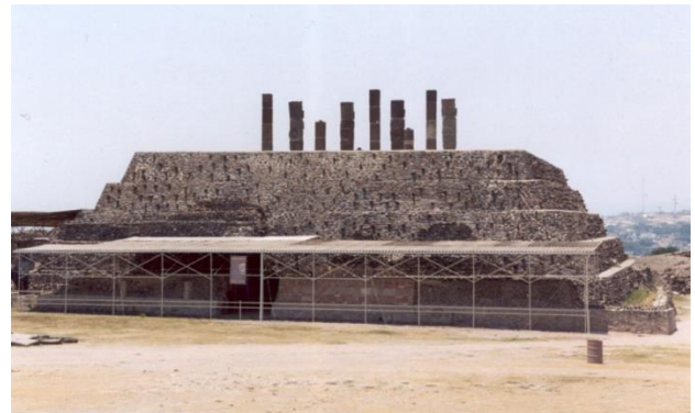
Imagen 27. Vista general de la fachada norte del edificio B. del Coatepantli.
