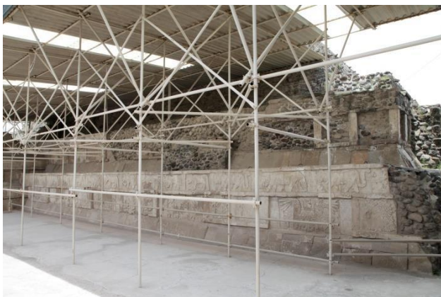
Imagen 26. Vista general de la fachada oeste. En ella se pueden ver los tres cuerpos de la pirámide donde hay relieves.
