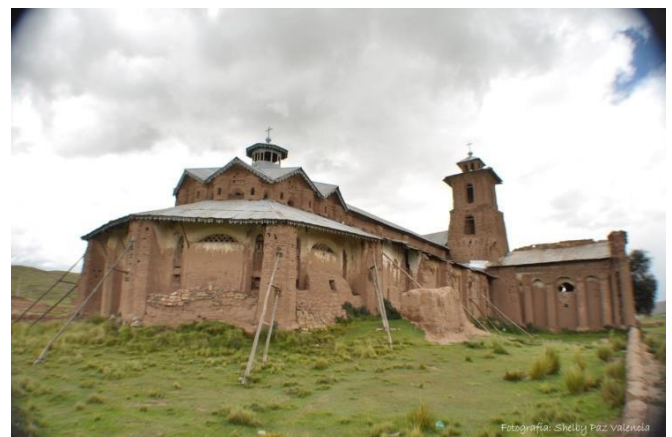
Imágenes 19 y 20. Fachada posterior hacia el muro del evangelio, se observa el ábside poligonal, ornamentación posterior de altares, torre lateral hacia el fondo y capilla lateral.
