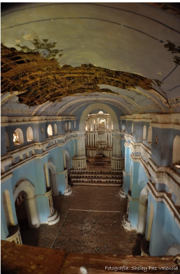
Imagen 22. Vista interior de la nave central del templo, la falsa bóveda sobre un encañado y vigerías de madera.
