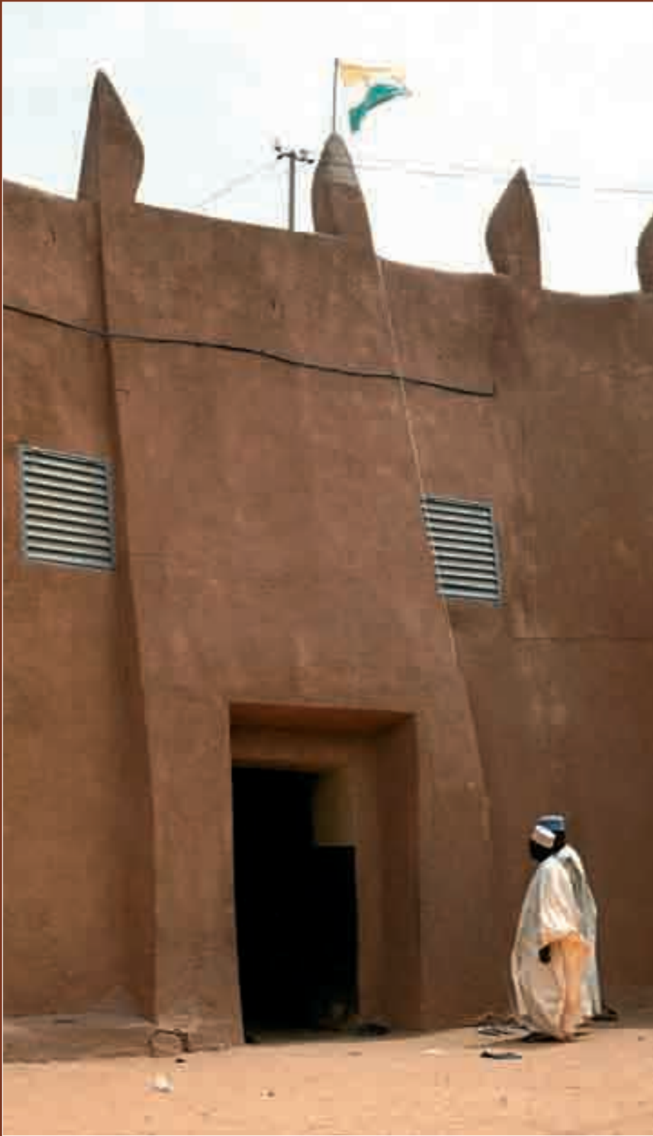
FIGURE 53 Entrée du Palais.
