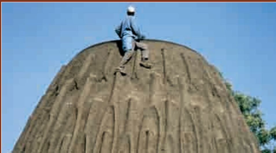
FIGURE 93 (en haut) Les moulurations servent, entre autres, d'échaffaudage permanent.
