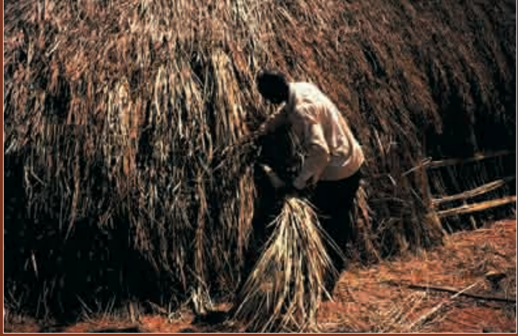
FIGURE 46 Mise en place de nouveaux fuseaux de paille par un membre du clan Ngeye.
