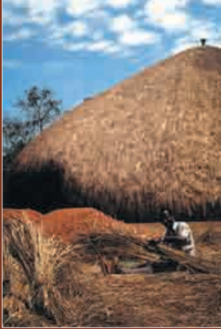
FIGURE 45 Préparation des fuseaux de paille pour les travaux.
