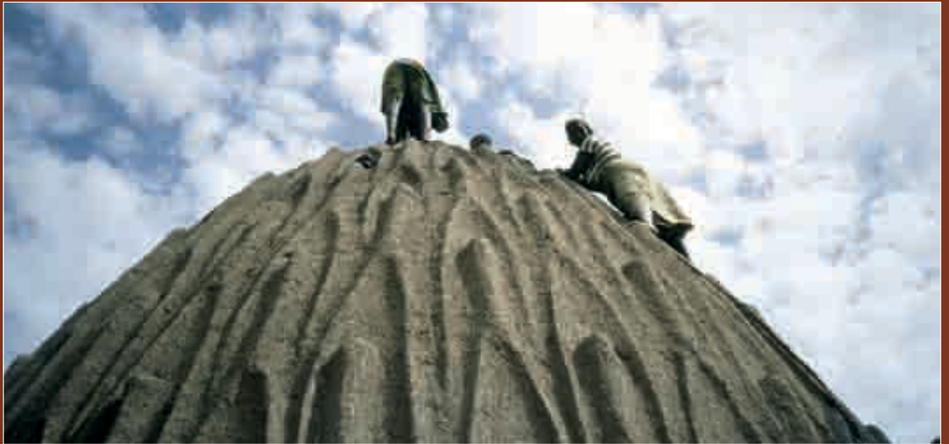
FIGURE 93 (en haut) Les moulurations servent, entre autres, d'échaffaudage permanent.
