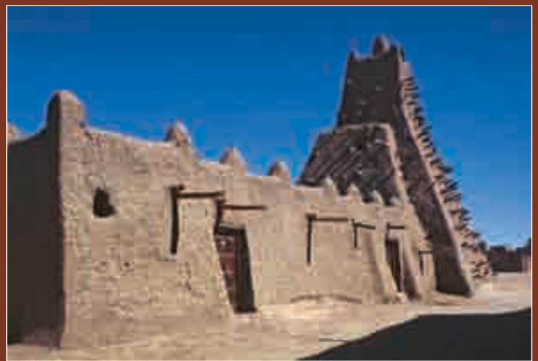
FIGURE 29 (en haut à droite) Mosquée de Sankoré, réfection de la façade Ouest et remplacement des gargouilles. Décembre 1996.
