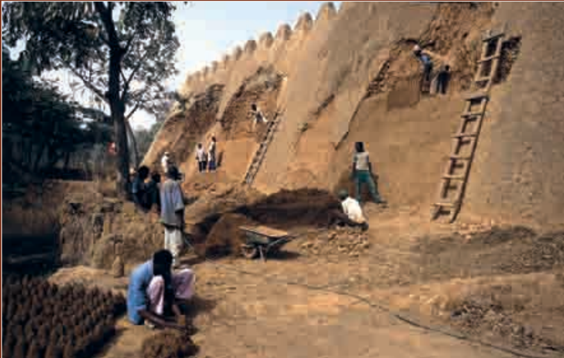
FIGURE 4 Restauration de la réplique de la muraille de Kano, Musée d'architecture de Jos, Nigéria.
