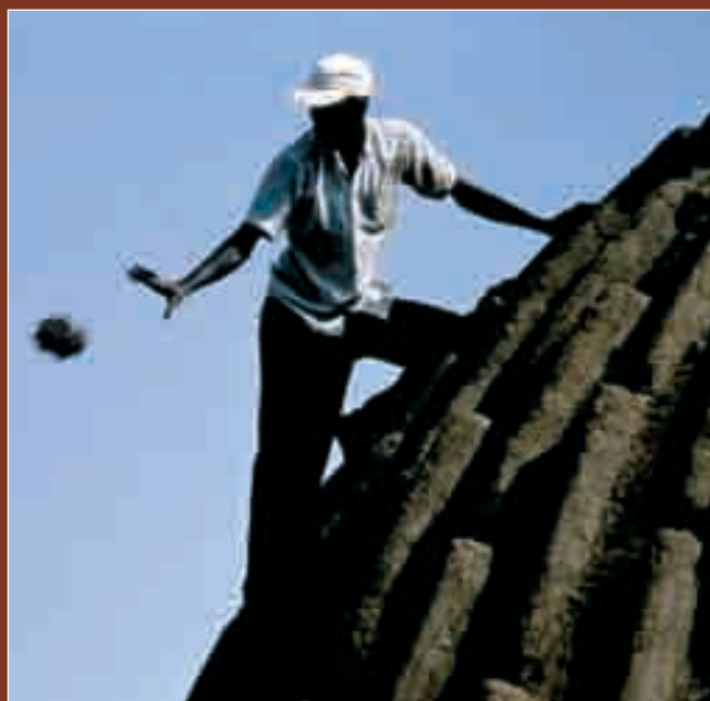
FIGURE 95 (en haut) Le lancer de boule de terre. Une astuce pour construire vite et au moindre effort.
