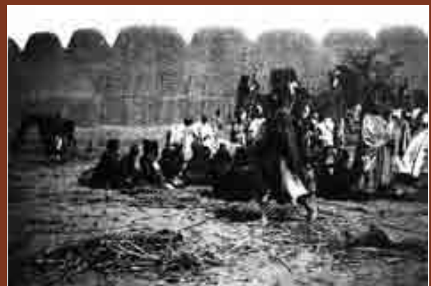
FIGURE 59 La grande muraille de Birni lors des travaux de réfection de l'enduit, sans doute vers 1900, à une époque où le sultan pouvait facilement mobiliser les maçons et la population pour mettre en oeuvre les travaux d'entretien.
