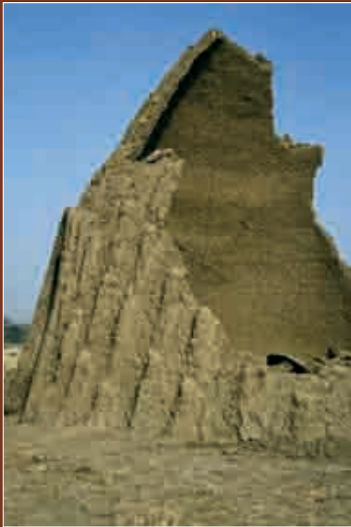
FIGURE 98 Une case abandonnée nous montre la fine épaisseur des parois.
