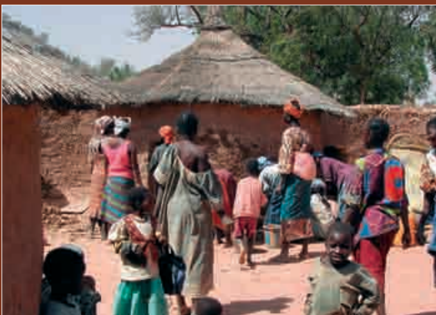
FIGURE 14 Un groupe de femmes rénovant l'enduit traditionnel des murs.
