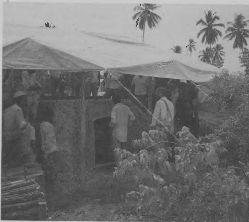
Zanzibar, Tanzanie. Four à chaux artisanal construit dans le cadre d'un cours de formation à l'intention de producteurs locaux de chaux.
