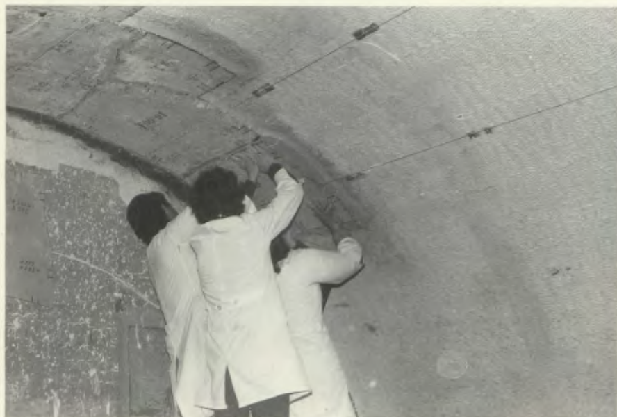
6. Ελαστοποθέτηση ψηφιδωτών στις καμάρες
