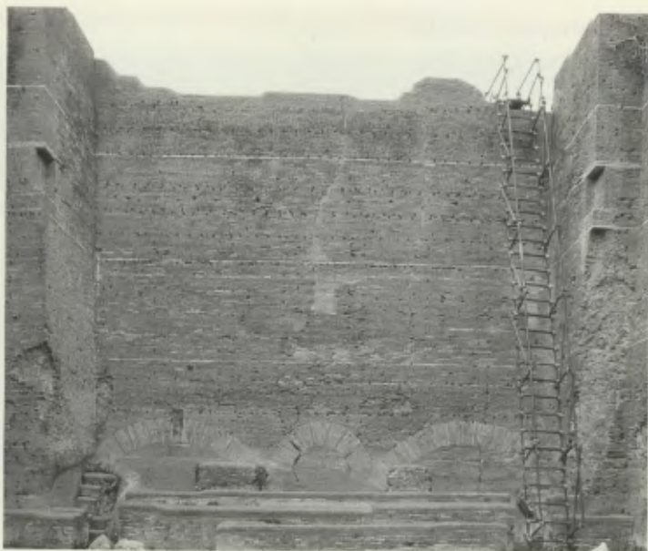
4. Ostia, Capitolium , interno della cella. Sulle pareti sono ben evidenti i fori per l'alloggiamento delle grappe metalliche usate per il fissaggio delle lastre marmoree di rivestimento.
