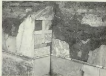
4. Ostia, Capitolium , interno della cella. Sulle pareti sono ben evidenti i fori per l'alloggiamento delle grappe metalliche usate per il fissaggio delle lastre marmoree di rivestimento.
