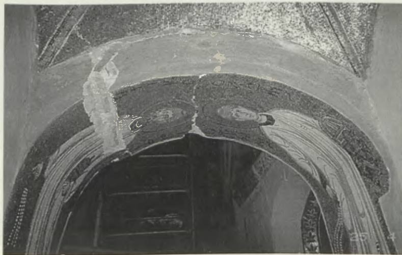
1. Κατάρρευση τμήματος και ρηγμάτωση στο ΝΔ τόξο.
