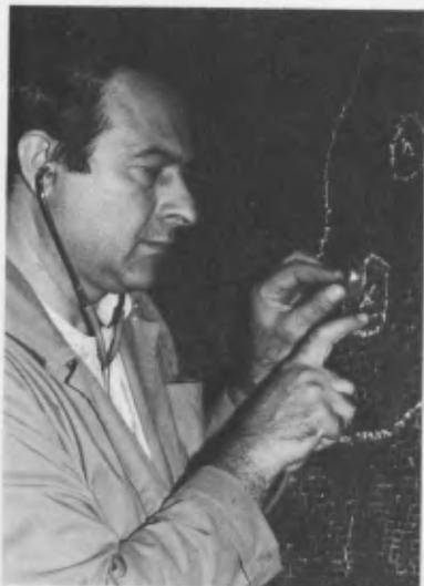
Figure 1. Prima di iniziare il consolidamento del manto musivo e dei suoi supporti, è bene rilevare il degrado, punto per punto, delle aree del distacco, ovvero individuarle a mezzo dell'auscultazione, con l'ausilio di apparecchio stetoscopico. La diagnosi sarà della compresenza di tutti i tipi di distacco.
