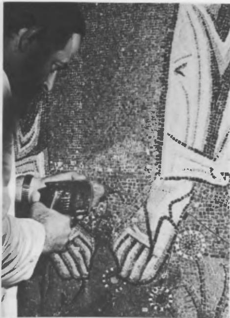
Fig. 4. - Esecuzione di un foro per giungere fino al punto di stacco.
