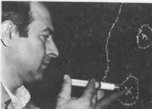
Figure 3. Prima di iniziare il consolidamento, si inietta acqua ed alcool. Questa soluzione serve per eliminare i residui di malta polverizzata, del salnitro e di altre sostanze depositatesi nel corso dei secoli fino ad un lavaggio a rifiuto.
