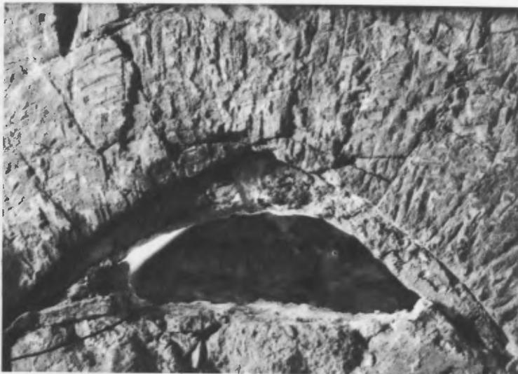
Fig. 1. - Paramento murario con tracce di scalpellature.
