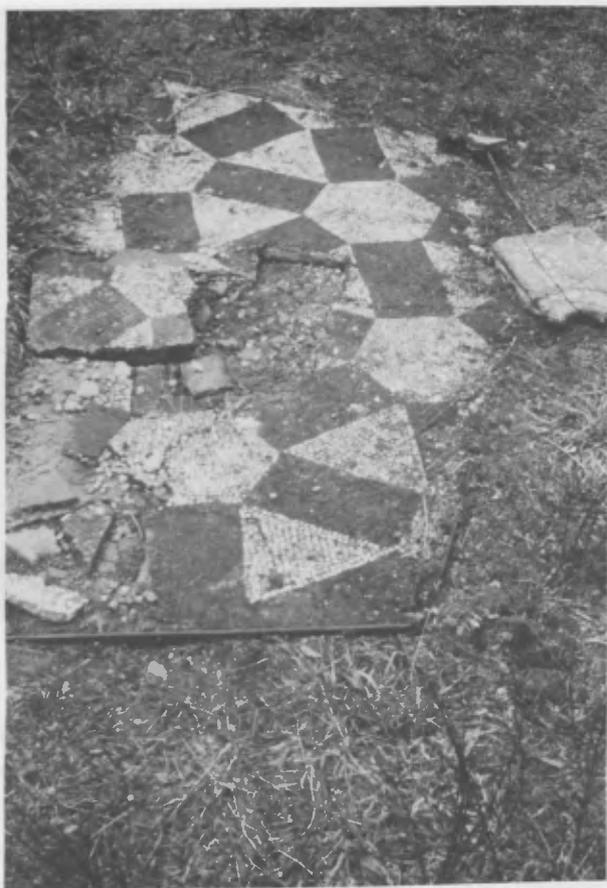
Fig. 6 Ostia, Castel Fusano, Villa di Plinio. Altro esempio di restauro a blocchi grandi e soletta in cemento e tondini di ferro. La figura mostra in modo evidente il grave dissesto subito dal mosaico a causa della reattività di cemento e ferro agli agenti atmosferici e all'azione delle erbe infestanti, cui la mancata manutenzione ha dato libera crescita. Questo mosaico è stato restaurato nel 1975!
