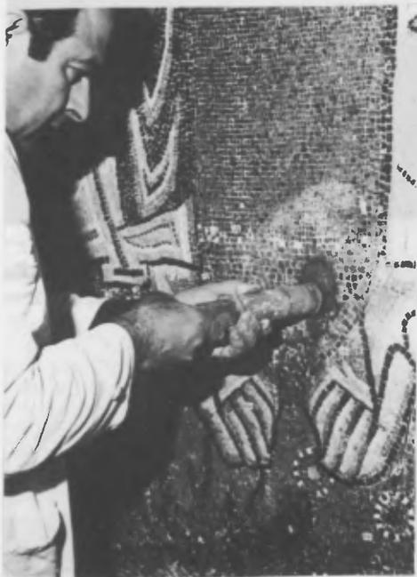
Fig. 5. - Esecuzione dell'iniezione consolidante.
