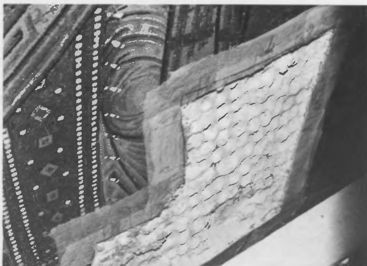
Fig. 2. - Primo strato di malta con intaccature intenzionali.
