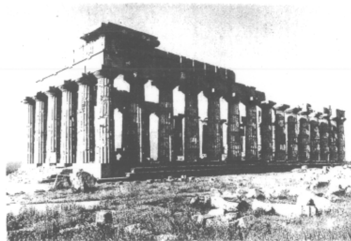
Fig. 22. Selinunte, Tempio di Hera. Elementi costruttivi originali allettati in cemento armato. Errori considerabili dal punto di vista scientifico nella ricostruzione che non possono più essere corretti e dubbi sulle decisioni di tipo estetico: un precedente tempio greco dell'età classica è stato parzialmente distrutto con questa ricostruzione.
