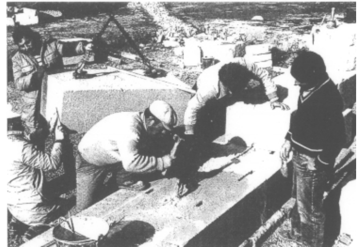
Fig.19. Metaponto, teatro. Pietra naturale utilizzata nella ricostruzione del muro esterno, con uso fedele della vecchia tecnica di lavorazione.
