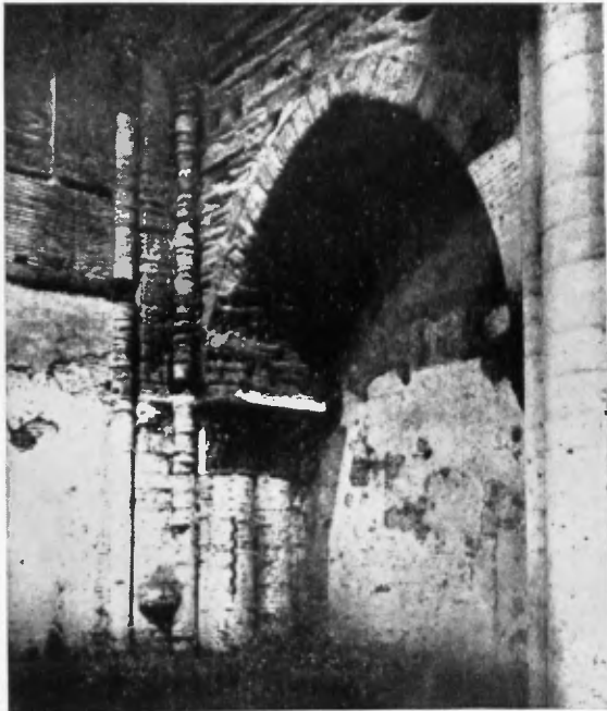
FIG. 26.—Interior de la Catedral de Lérida. Conversión en arena siguiendo zonas paralelas al lecho
