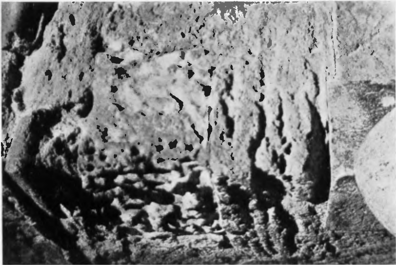
FIG. 20.— Catedral de Granada. Formación de surcos y orificios
