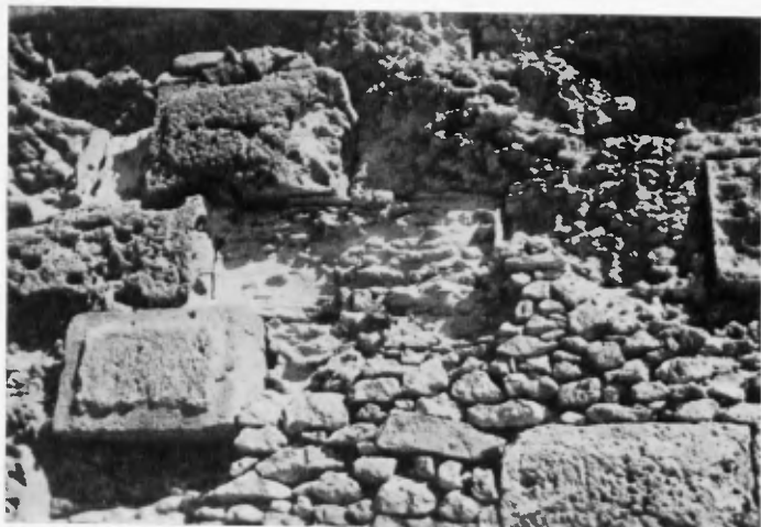
FIG. 11 (p. 66) — Cathédrale de Tarragone. Formation de sillons et d'orifices parallèles au lit.
