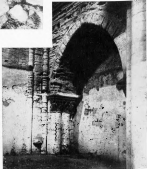
FIG. 26 (p. 91) — Intérieur de la Cathédrale de Lérida. Conversion en sable selon des lignes parallèles au lit.
