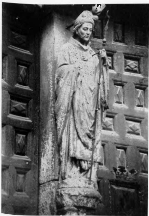
FIG. 2 (p. 54) — Calcaire de Hontoria. Porte du Sarmental de la Cathédrale de Burgos. Détachement de croûtes.
