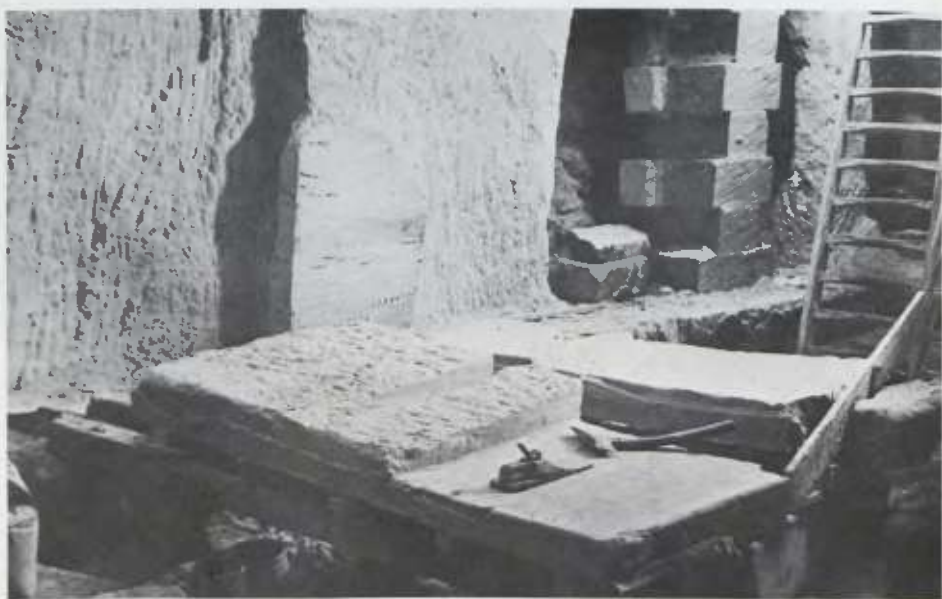
Pl. 138 - Dépose par stacco a massello d'une peinture d'une église rupestre de Matera (Pouilles).
