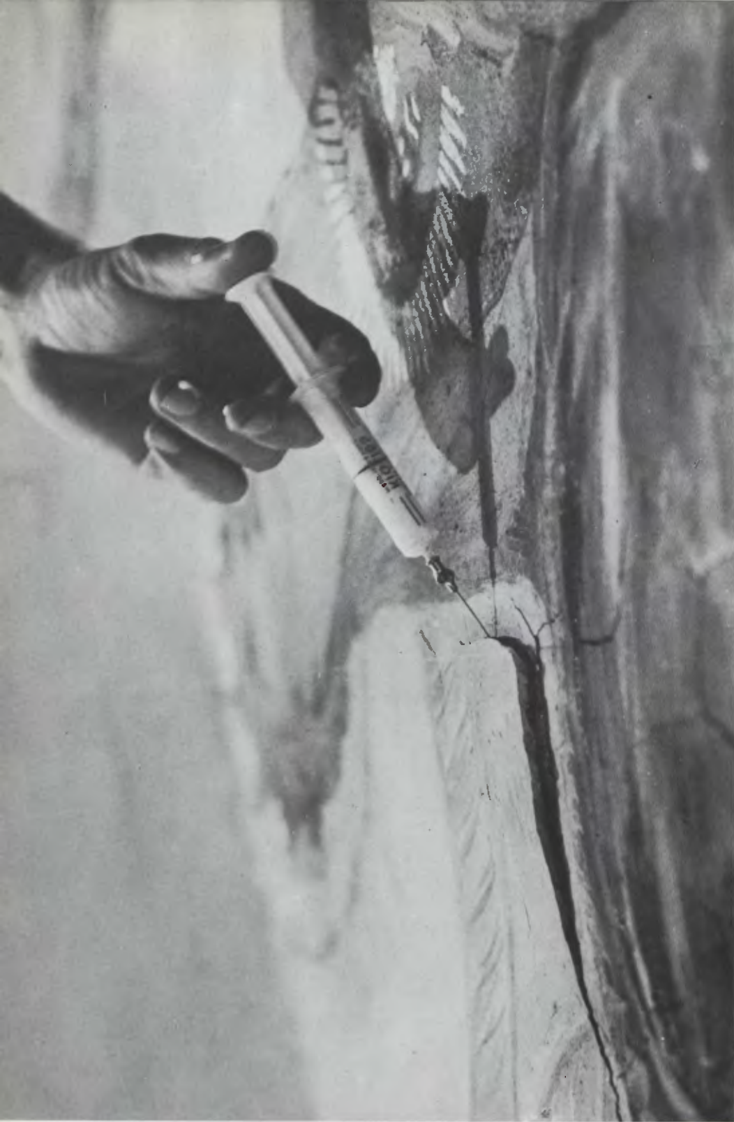
Pl. 133 - Fixage par injection d'adhésif à la seringue.
