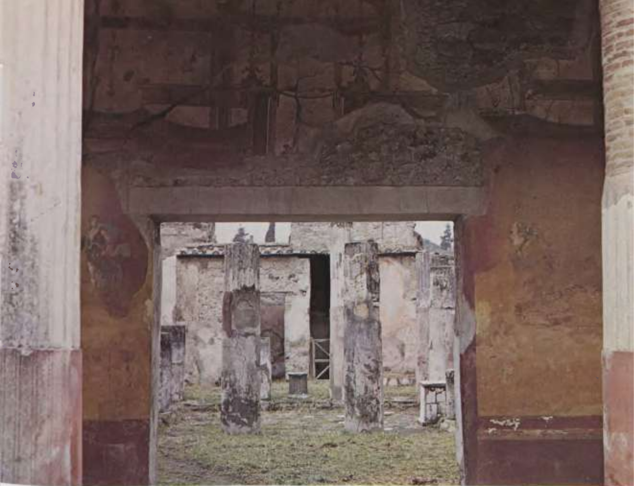
Pl. VIII - Altérations de l'ocre jaune en ocre rouge sous l'effet de l'incendie provoqué par l'éruption du Vésuve de 79 ap. J.C. Noter la zone atteinte, située autour de la poutre dont la combustion a fourni la chaleur qui a provoqué l'altération de l'oxyde de fer hydraté en oxyde de fer anhydre. Pompéi: Maison de Castor et Pollux, péristyle.
