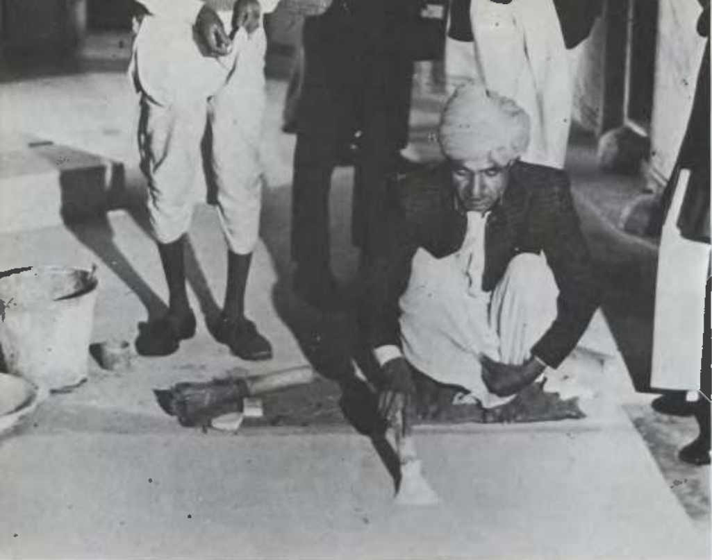
Pl. 42 - Amber Fort (Rajasthan). Artisan exécutant un pavé dans la technique traditionnelle de « fresco lustro » local. Noter l'application au pinceau des dernières couches et la pierre utilisée pour le polissage.
