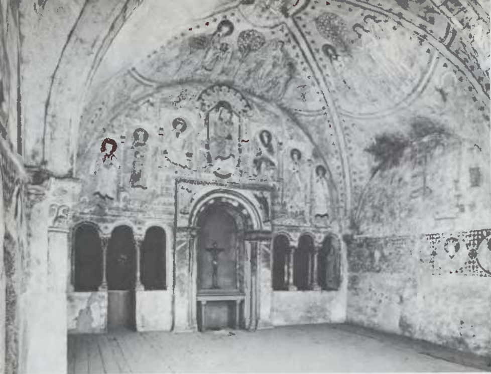
Pl. 14 - Gurk, Tribune occidentale de la cathédrale: La Vierge transfigurée sur le trône de Salomon (1260-70). La peinture murale, complétée de reliefs de stuc doré, s'intègre dans la construction architectonique en la développant (arcades, gradins, etc.) et se prolonge sans faille dans la polychromie des éléments architectoniques (arcades, arcatures, colonnes et pilastres).
