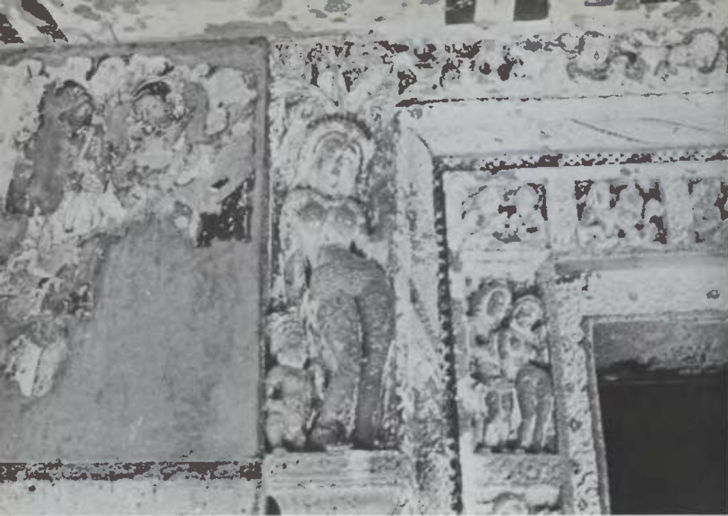
Pl. 5 - Ajanta. Entrée d'une grotte (Ve siècle). L'opération de restauration, exécutée au début du XXe siècle, s'est limitée au traitement du décor des surfaces planes des parois, négligeant la polychromie des parties sculptées qui en est inséparable. L'extension d'une couche d'enduit neuf sur une partie de la paroi a encore contribué à briser l'unité de l'ensemble en traitant la peinture pariétale comme s'il s'agissait d'un panneau appliqué, indépendant.
