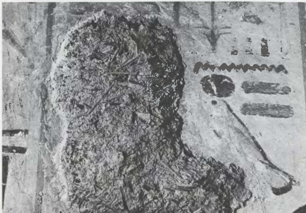
Pl. 34 - Tombe égyptienne, XVIIIe Dynastie. Détail de peinture détériorée montrant l' arriccio d'argile et de paille sous l' intonaco de gypse.
