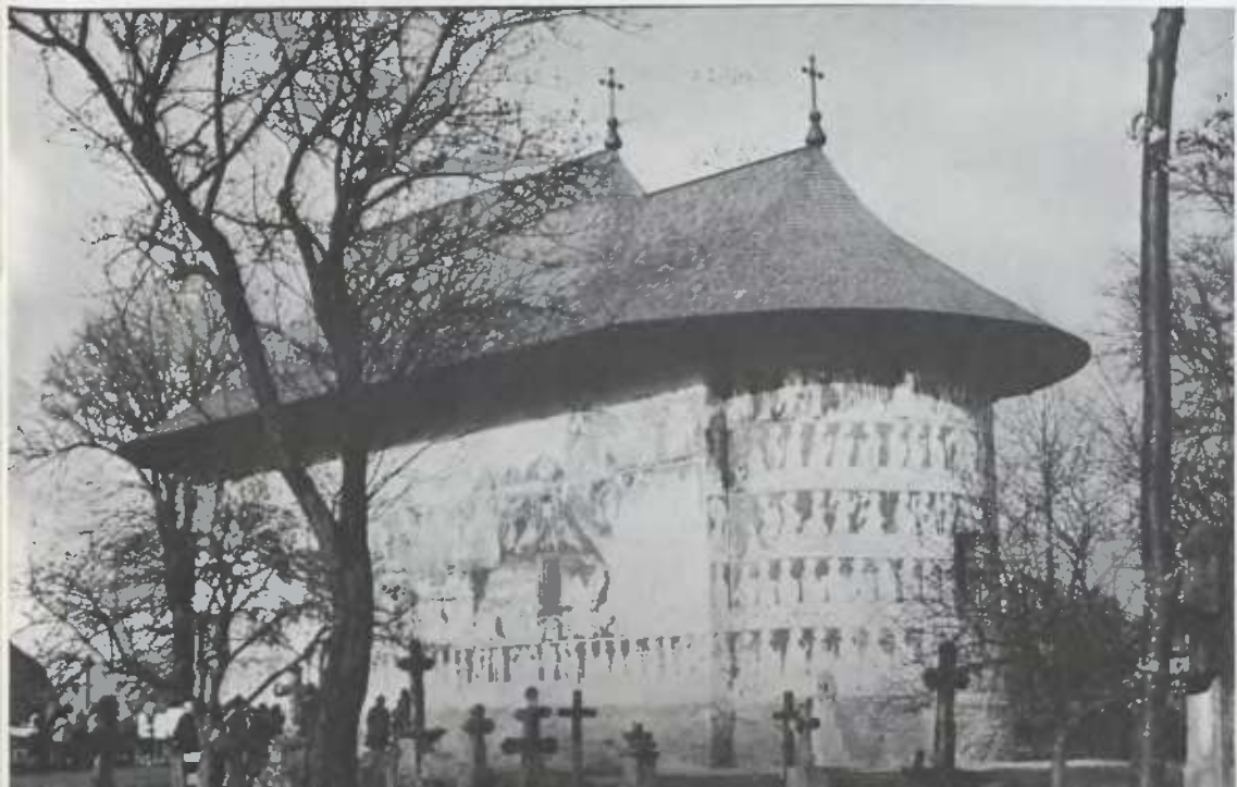
Pl. 132 - Arbore (Roumanie). Vue de l'église du sud-ouest, montrant l'altération croissante de la peinture de haut en bas, selon son exposition aux intempéries, et la résistance exceptionnelle des fonds bleus.
