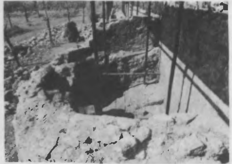
7. et 8. Thermes de Cotilia. L'allègement de la pousse du terrain au moyen de la création d'une "boutonnière" derrière le deuxième terrassement (à gauche) et avec le vidage de l'absidiole du terrassement inférieur (à droite). (Photos 1988).
