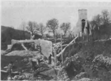
9. La fouille pour la création du drainage. (Photo janvier 1989).
