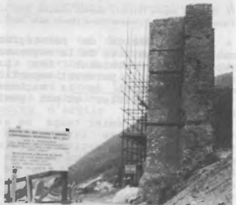
14. Le premier éperon oriental réintégré dans le noyau de la maçonnerie et dans le parement dans un but statique ainsi que didactique. (Photo j. 1989).
