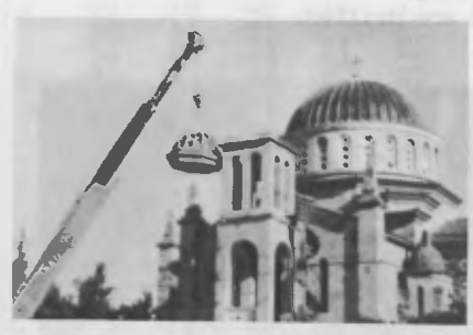
Φωτ.6. Επανατοποθέτιση του τρούλου Foto 6. Replacement of the dome.
