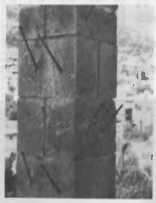
Φωτ.5α,5β. Τα ρητινόβλιτρα „Μετίοπλισμός” των πεσσών. Foto 5a,5b. Epoxy "short root-piles". Post reinforcement of columns.
