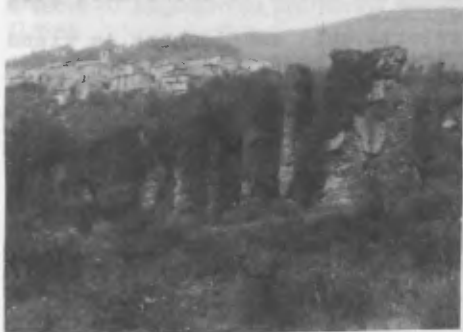
11. Castel S. Angelo (Rieti), thermes romains: état de l'ensemble avant les restaurations. (Photo mars 1987).
