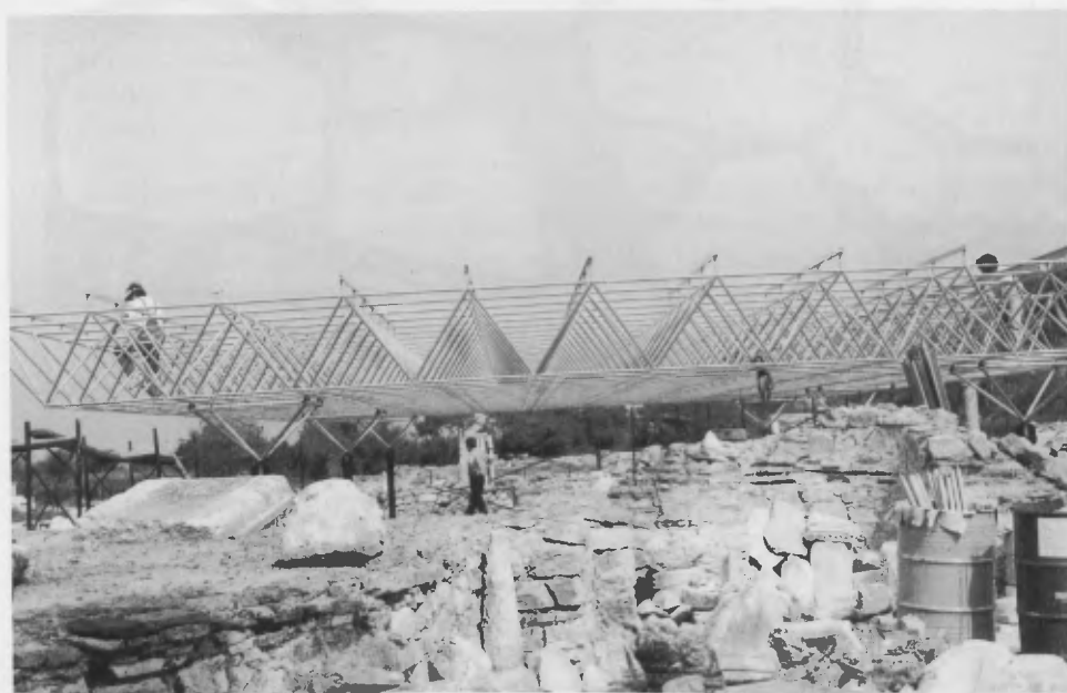
Figs 2-3: Philippi. La toiture du pavement en mosaïque de la "Basilique de Paul" en cours de construction.
