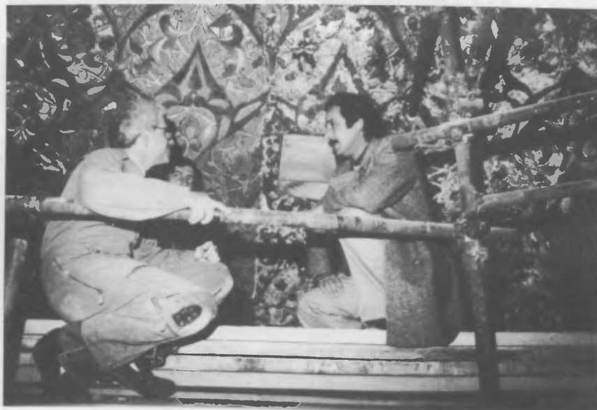
Mosquée Al-Aksa, Jérusalem. A droite: Isam Awwad, architecte résidant; à gauche: Paul Schwartzbaum. Remarquer la partie traitée, à gauche.
