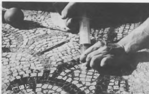
Injection d'un liant à base de chaux hydraulique dans une mosaïque pavimentale d'Ostia antica.
