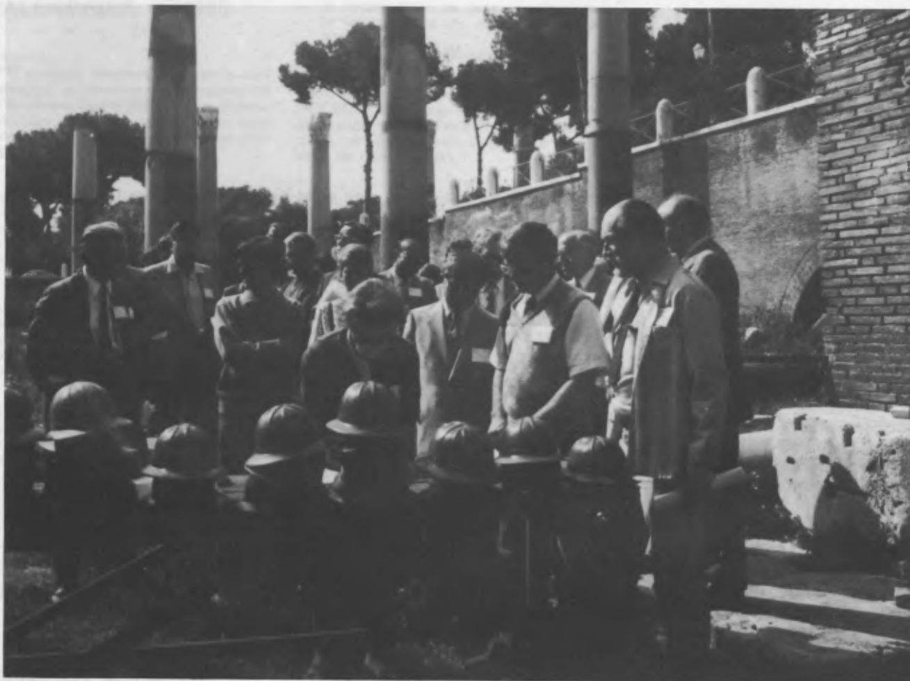
Les délégués de l'ICCROM mettent leurs casques avant de monter sur les échafaudages de la colonne Trajane.
