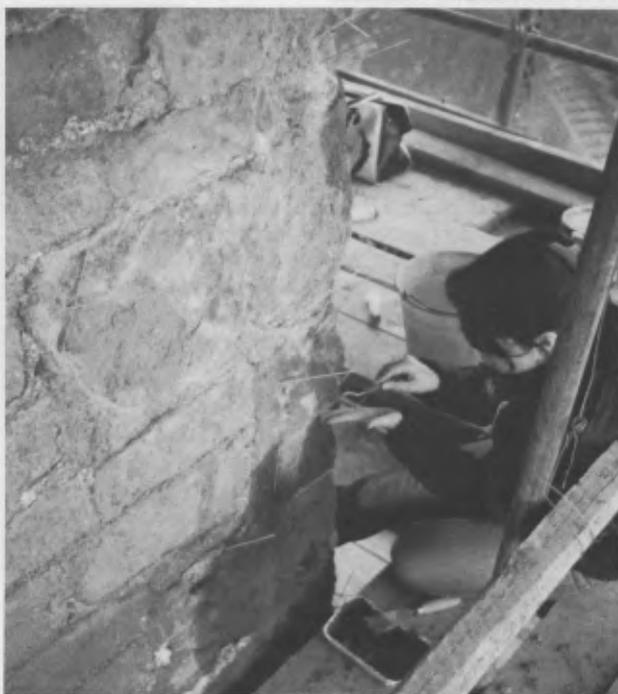
*Un restaurateur scellant une portion de mur à consolider. De fines pièces de bois sont insérées afin de ménager des trous pour injecter des liants.*
