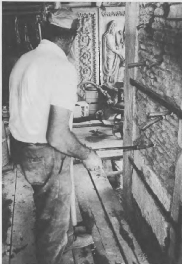
Rome: Arco degli Argentari. Des trous atteignant jusqu'à 1,20 m de profondeur ont été percés sur les côtés du pilier à consolider, vu ici de l'arrière. Après humidification de la structure, un coulis a été injecté de bas en haut.
