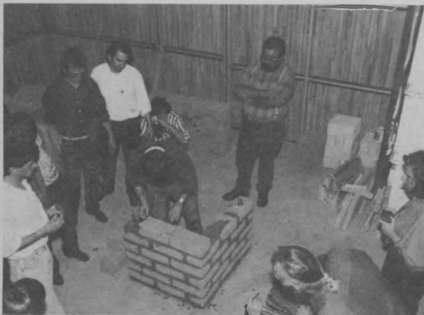
Exercice pratique de construction d'un mur en briques de terre.
