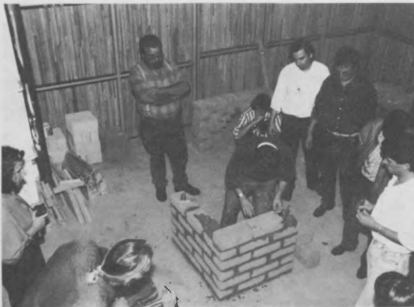
Ejercicio práctico de la construcción de un muro en ladrillos de tierra.
