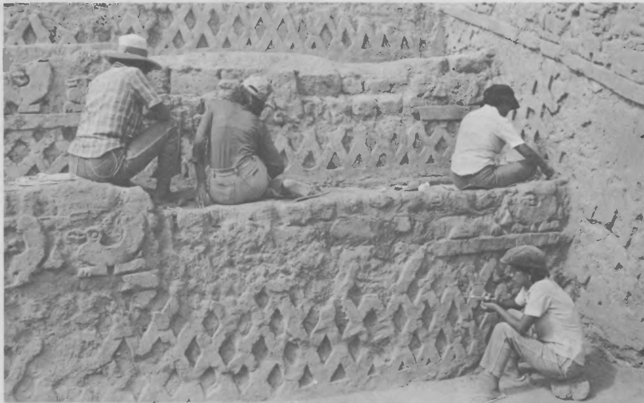
Restauración de monumento de adobe, Chan Chan, Perú: Proyecto piloto PNUD / UNESCO / ICCROM.
