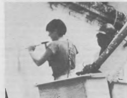
San Juan: Dentro de una grúa, J.-M. Teutonico toma muestras del mortero a varias alturas del edificio.
