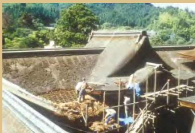
Utilisation d'écorce de cyprès pour la construction traditionnelle de toits au Japon
