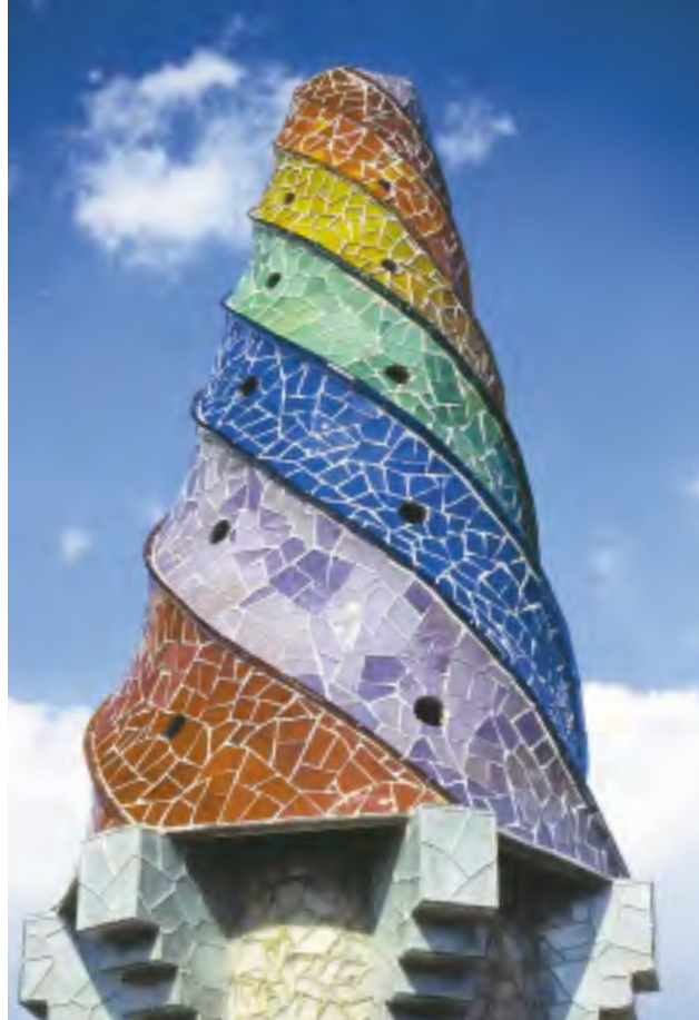
Céramique émaillée appliquée à l'architecture. Cheminée sur le toit du Palau Güell d'Antoni Gaudi, à Barcelone (Espagne). Revêtement de Robert Llimos. Photo Antoni González Moreno-Navarro.
