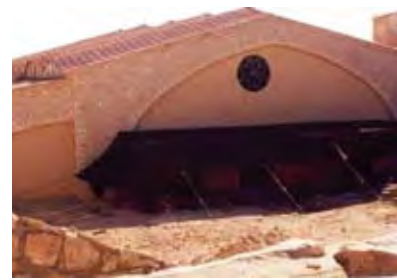
Estructura de protección sobre la Iglesia de los Apóstoles, Madaba, Jordania. La orientación Oeste de la fachada y el uso de vidrio determinaron que los mosaicos resultaran dañados por la radiación solar. Esto motivó que el vidrio se sustituyera por cemento y paneles de madera.
