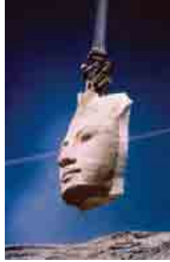
Abou Simbel, Egypte. Démontage du temple de Ramsès II à l'aide d'un mât de charge. © UNESCO/Nenadovic
