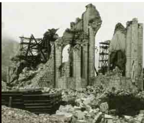
Frioul, 1976. Gauche: Abside du Duomo de Venzone, après la première secousse. Droite: La même abside après la deuxième secousse. L'ICCROM a participé au relevé photogrammétrique effectué après la première secousse et qui a servi pour la reconstruction de l'église.
