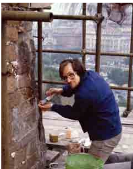
J. Malliet, 1985. Dans le cadre des activités de l'unité spécialisée dans les mortiers (RTU), un enduit hydraulique est injecté dans les tours du Campidoglio à Rome.
