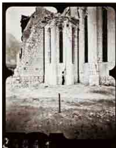
Frioul, 1976. Gauche: Abside du Duomo de Venzone, après la première secousse. Droite: La même abside après la deuxième secousse. L'ICCROM a participé au relevé photogrammétrique effectué après la première secousse et qui a servi pour la reconstruction de l'église.
