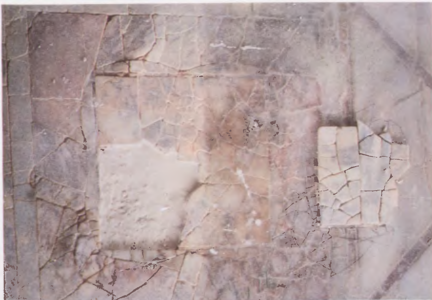
Fig. 3.— Riallettamento di porzione di formella del sectile.
