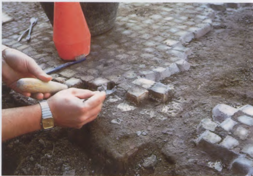
5. Stuccatura di contenimento dei bordi. (Foto: M. Anastasi).
