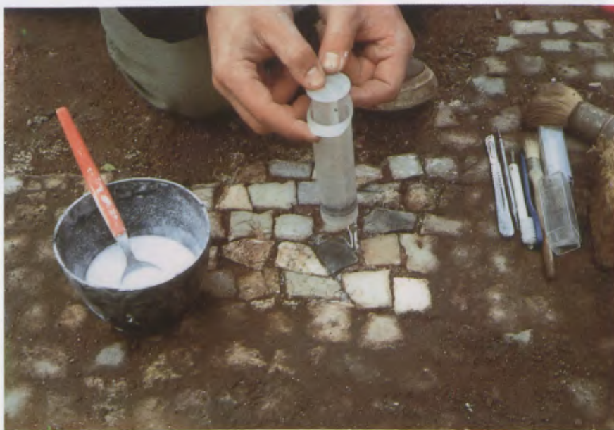
4. Consolidamento: infiltrazione preventiva di emulsione acrilica Primal AC33. (Foto: M. Anastasi).
