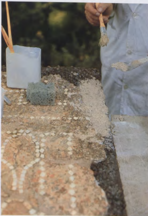
Fig. 2. — Ricomposizione in piano del pavimento “A”, con posa a lato dell’originale dello strato di calce e materiali leggeri, argilla e mica espansa (perlite), già impiegato nella preparazione del nuovo strato interposto.
