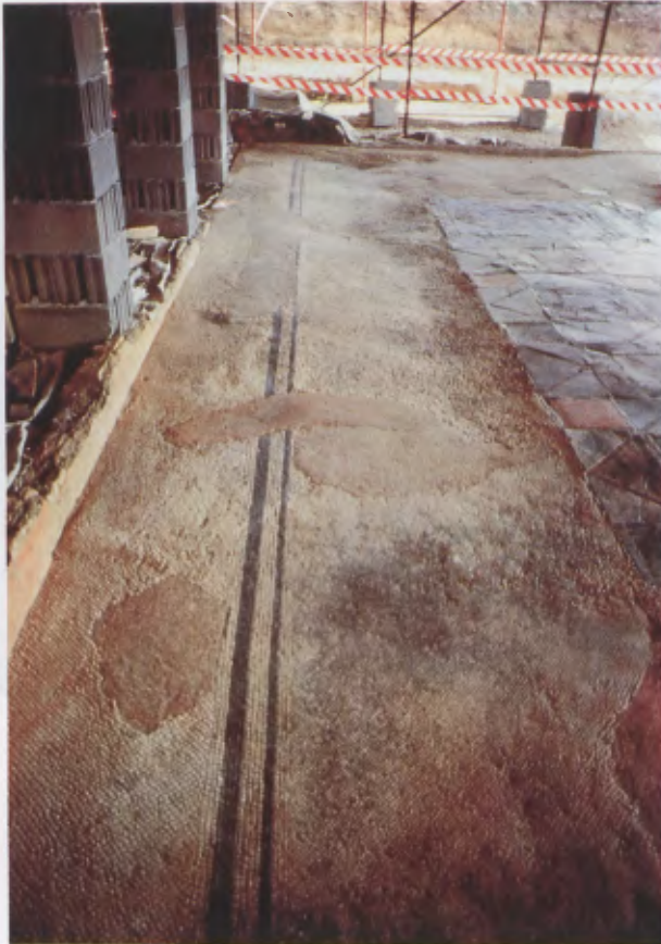
Fig. 7.— Sprofondamento sul lato ovest; adeguamento del profilo dei bordi e colmataura fossa.
