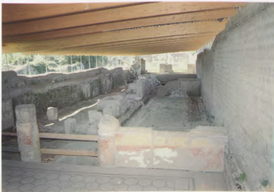
Ostia: tettoia in Legno Lamellare.
