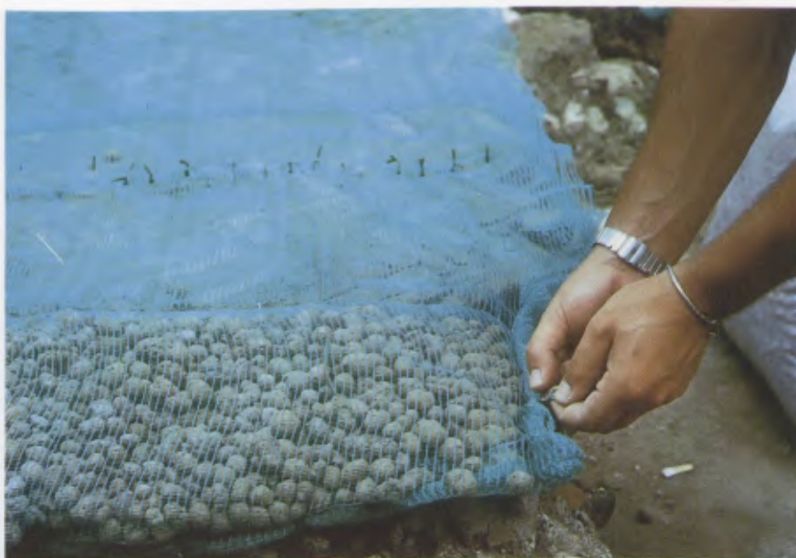
3. Protezione delle superfici mediante copertura temporanea con argilla espansa. (Foto: M. Anastasi).
