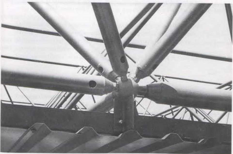
Fig. 4 – Pormenor da estrutura espacial em fase de montagem.
