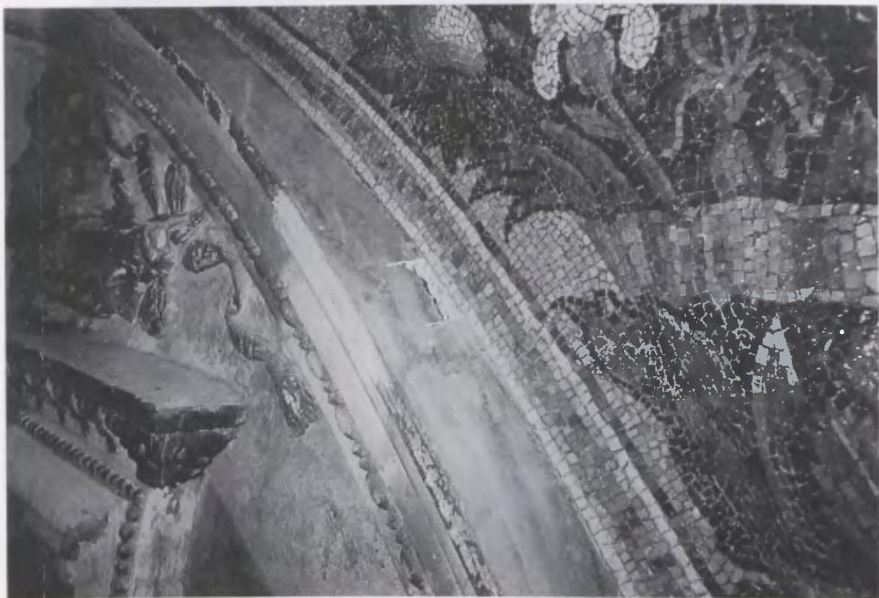
**Fig. 7** – Tassello eseguito sulla cornice di una lunetta (lato lungo). Foto di Sergio Ferrante -Archivio S. B. A. A. R.
