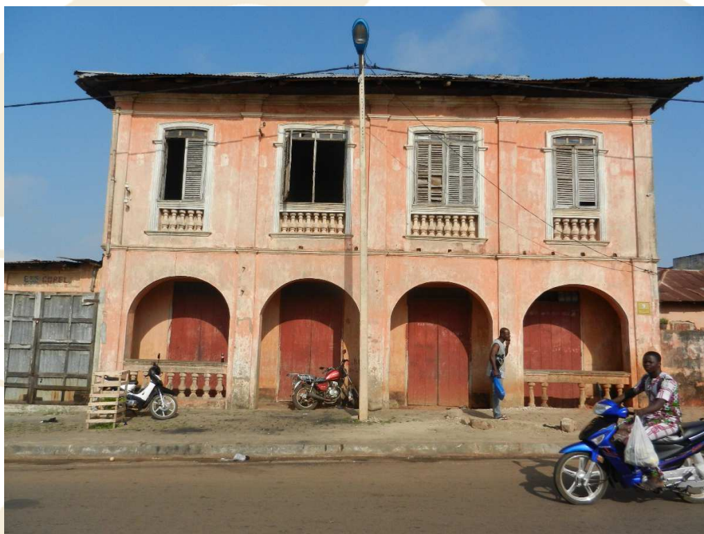
Maison Padonou de Porto Novo- Edificación Agudá: Restauración, 2014
