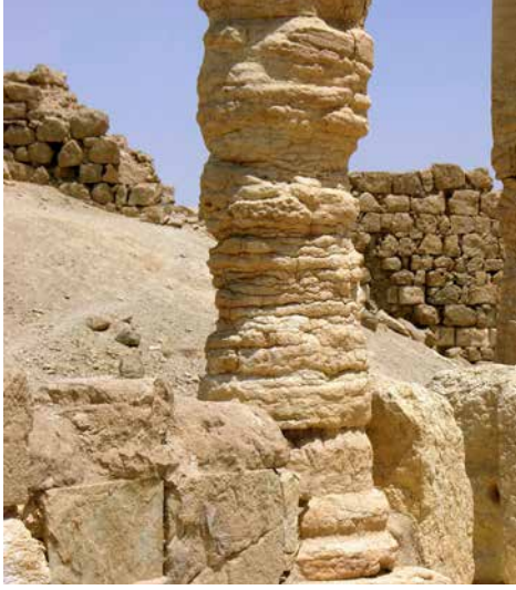
التعرية بفعل الرياح التي لحقت بأحد الأعمدة في موقع تراثي (نشرت الصورة بإذن من السيد أنور سابق، منظمة إيكروم).
