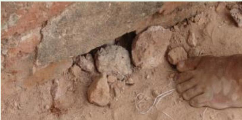
*Trous dans le système d'étanchéité du toit d'une pagode à Bagan, Myanmar, 2016. Photo : Eugénie Crété.*
