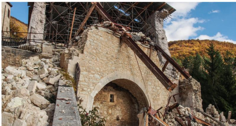
*Danos em estrutura de alvenaria por ação sísmica, Itália, 2017.
