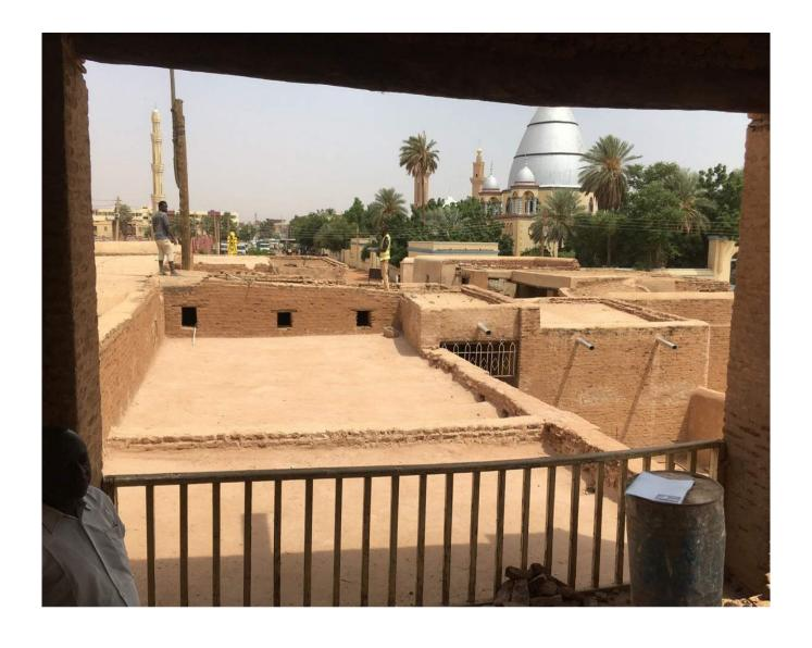
The roofs were rebuilt using khalija, a traditional lime mortar. . أعدنا بناء السقوف باستخدام الخفجة وهي الملاط التقليدي
