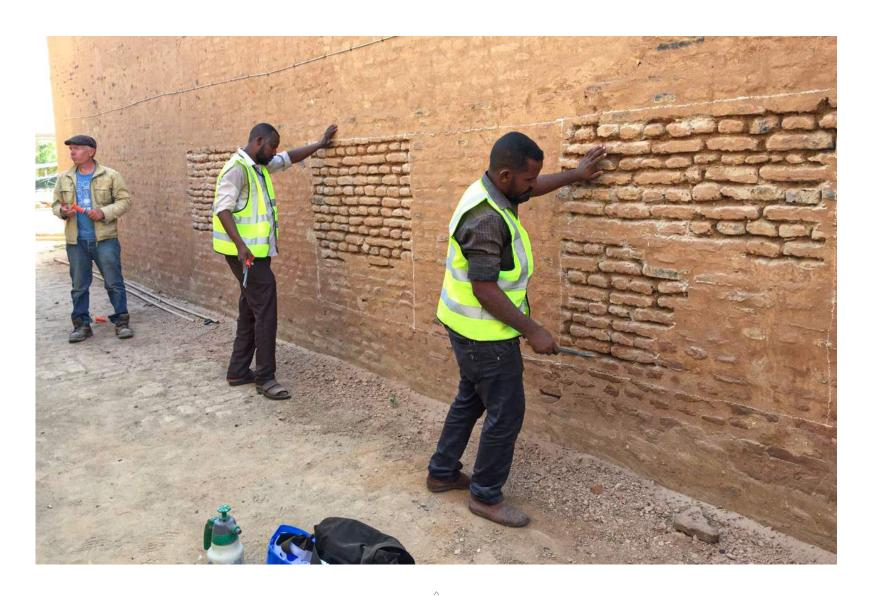
Trainees during the Architectural Conservation Workshop. Plaster testing and restoration using lime معماريون متدربون أثناء ورشة عمل الحفاظ المعماري. تجارب اختبار القصارة وترميمها باستخدام الجير
