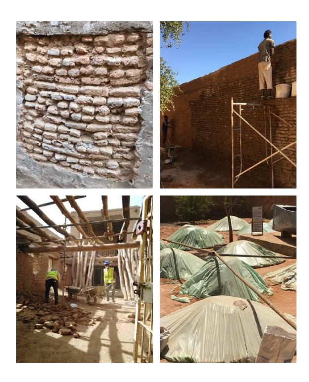
Restoring the Khalifa House included replacing cement plaster, preparing traditional mortar and restoring wooden roofs أثناء أعمال ترميم بيت خليفة استُبدلت القصارة الاسمنتية، وخُضِر الملاط التقليدي ورُممت السقوف الخشبية
