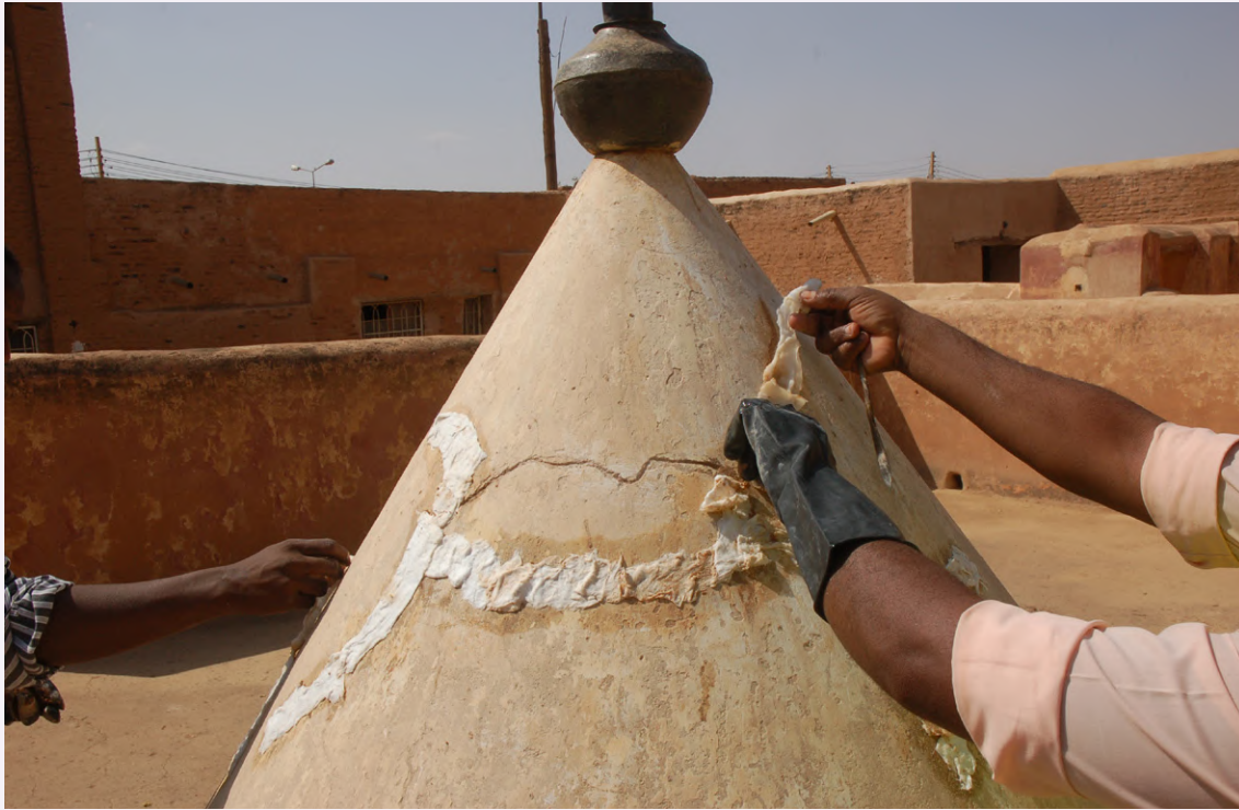
Conservation of the plaster of the Mahdi tomb dome during a course on architectural conservation ترميم قبة قسار قبة مريح المهدى، أثناء الدورة التدريبية على الحفاظ المعماري
