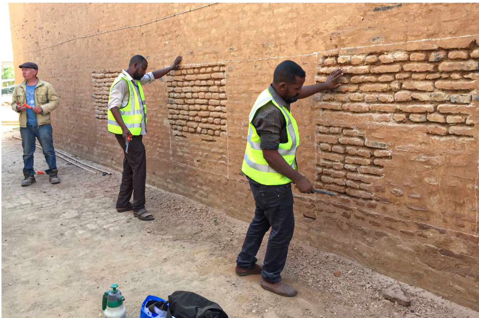
Trainees during the Architectural Conservation Workshop. Plaster testing and restoration using lime معماريون متدربون أثناء ورشة عمل الحفاظ المعماري. تجارب اختبار القسارة وترميمها باستخدام الجير
