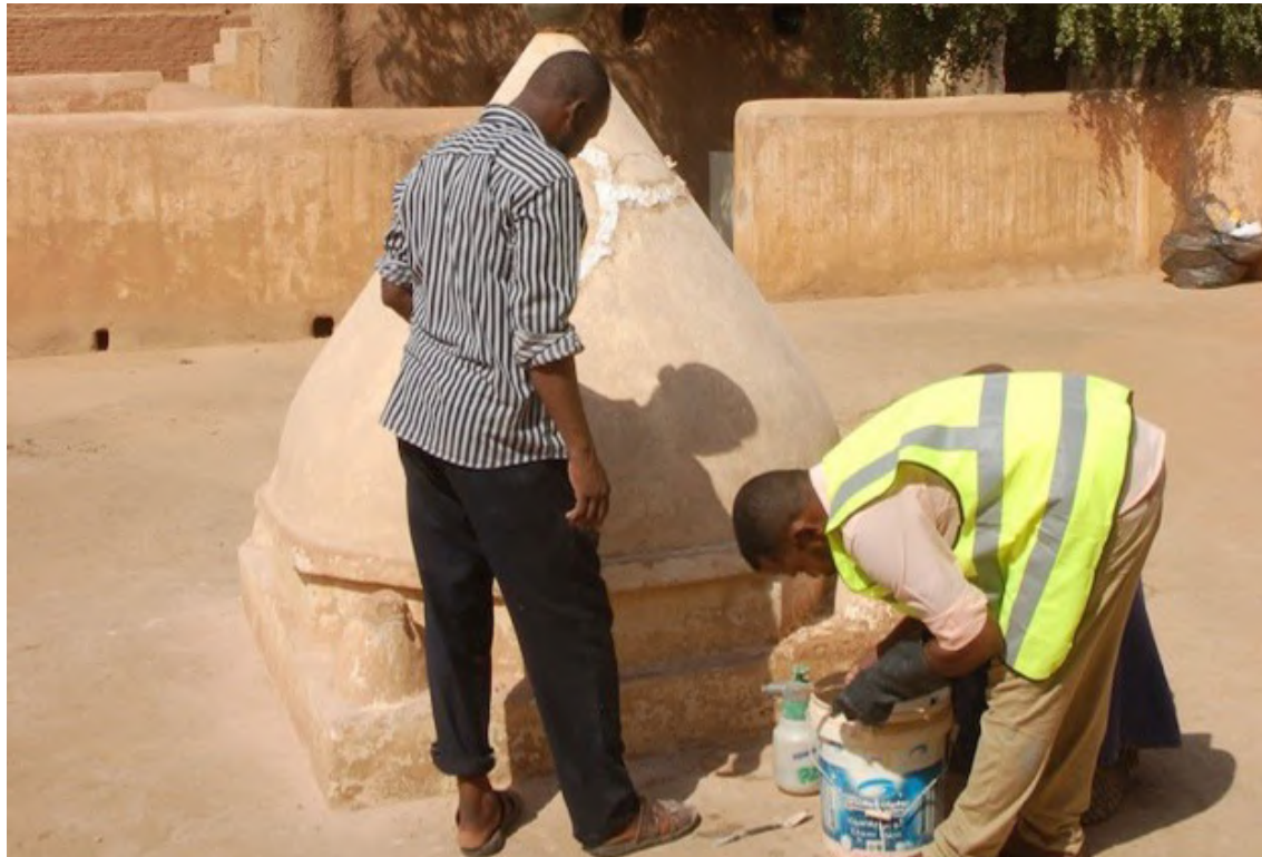
Restoration professionals during training to maintain the model of the Imam Mahdi Dome - the Caliph's Community House using traditional mortar فنيي الترميم أثناء التدريب على صيانة مجسم قبة الإمام المهدي- بيت الخليفة المجتمعي باستخدام الملاط التقليدي
