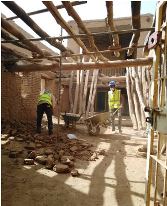
Restoring the Khalifa House included replacing cement plaster, preparing traditional mortar and restoring wooden roofs أثناء أعمال ترميم بيت خليفة استُبدلت القسارة الاسمنتية، وكُثر الملاط التقليدي وُثِّمت السقوف الخشبية
