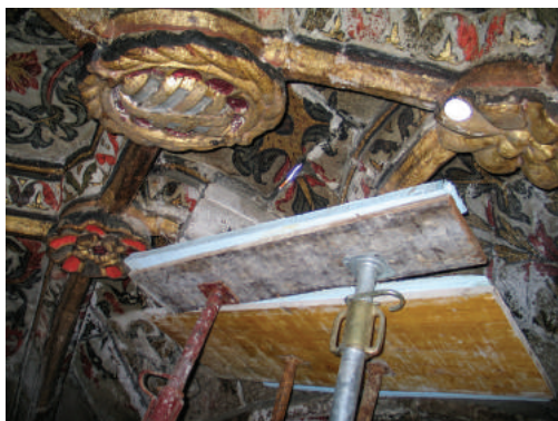
Shtresë mbrojtëse dhe izoluese midis pikturës murale dhe puntelës në kishën e Freixo de Espada à Cinta, Portugali, 2007. Foto: Esmeralda Paupério.
