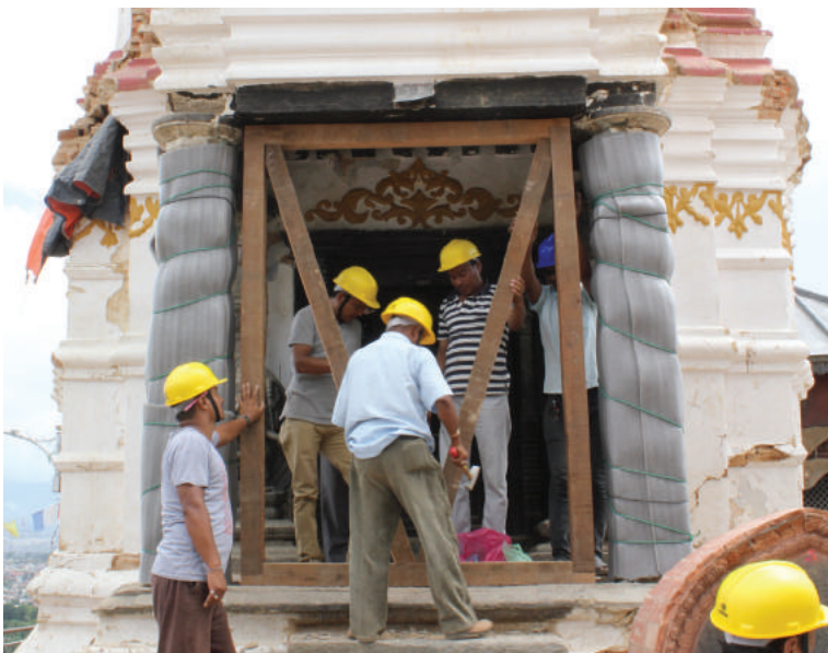
Stabilizimi emergjent i një tempulli në Kathmandu, Nepal, 2015. Foto: ICCROM.
