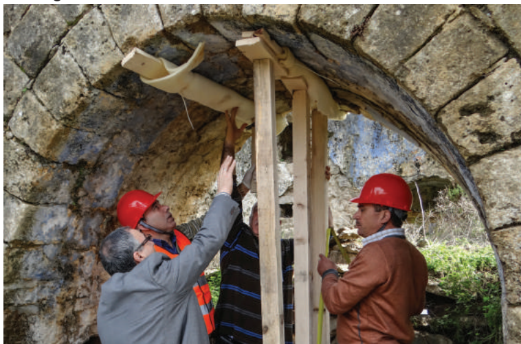
Vënia në praktikë e stabilizimit emergjent gjatë një punëtorie në Shouf, Liban, 2014 Foto: ICCROM-ATHAR.
