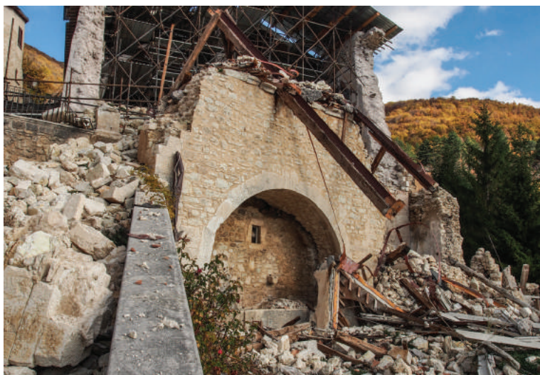
Strukturë pa kornizë e dëmtuar nga tërmeti, Itali, 2017.
