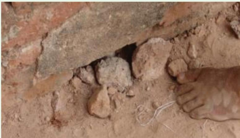
*Rupe u krovnom hidroizolacijskom sistemu pagode u Baganu, Mjanmar, 2016.
