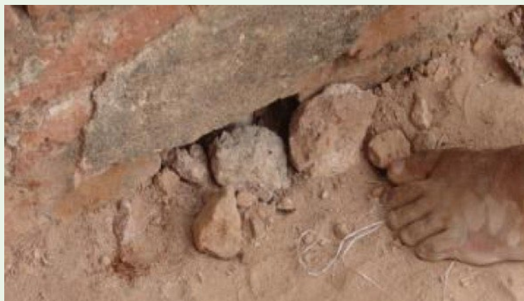
Дупки во системот за хидроизолација на покривот на пагода во Баган, Мјанмар, 2016 година. Фото: Еужени Крете.
