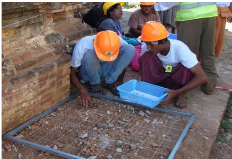
Мрежата за извлекување мали фрагменти од штуко-декорации на пагода во Баган, Мајнмар, 2016 година. Фото: ИКРОМ
